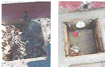
Foto 17: Sustitución de 2 cajas de registro.
