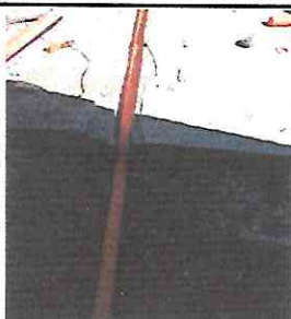
Foto 15: Sustitución de tubería pvc línea principal aguas negras
