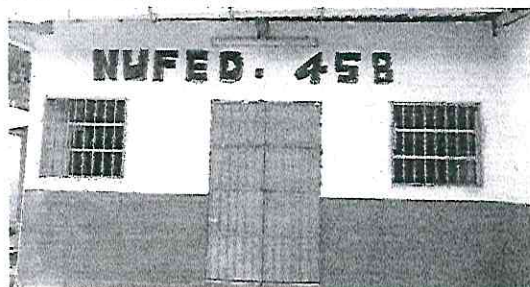
Foto 4: Fabricación e instalación de 2 balcones de hierro en ventanas, en vano de aula por falta de ventilación
