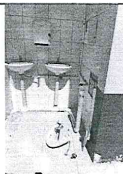
Foto 12: Sustrucción de 2 lavamanos
