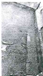
Foto 20: Sustitución de piso de torta de concreto, el actual esta deteriorado por lo que es necesario hacer la sustitución
