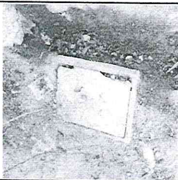
Foto 17: Sustrucción de 2 cajas de registro.
