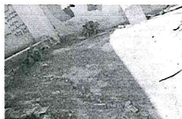
Foto 20: Sustitución de piso de torta de concreto, el actual esta deteriorado por lo que es necesario hacer la sustitución
