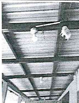
Foto 1: Sustitución de cableado eléctrico, incluye mano de obra.
