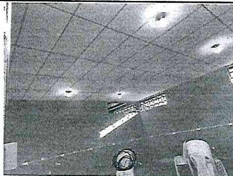
Foto 6. Colocación de cielo falso a 50 M2 en salon de computación.
