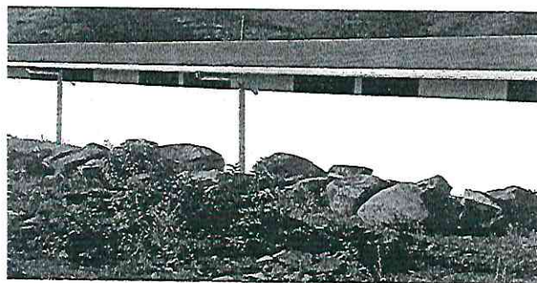
Foto 11. Bajada de agua pluvial.
