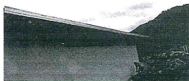
Foto 10. Fabricación e instalación de canales de metal.
