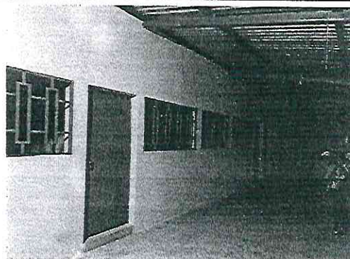
Foto 8. Fabricación e instalación de 2 ventanas tipo PVC de 2.35x1 en aulas.
