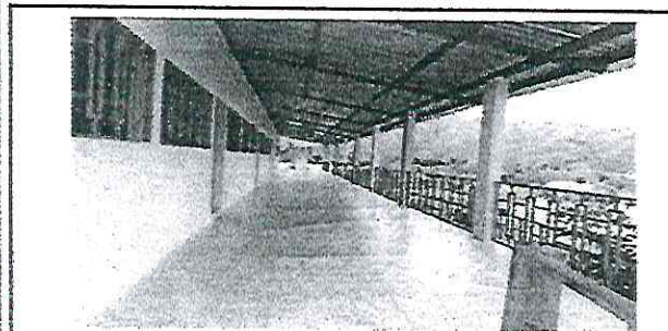
Foto 5: Fabricación e instalación de ventanas PVC 1.90X1.
