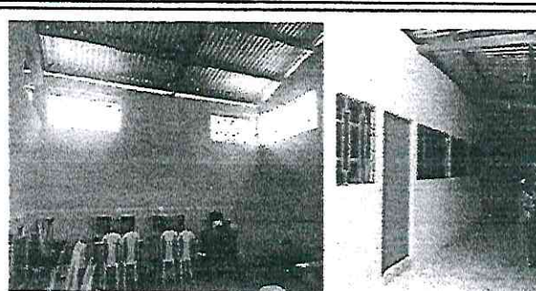
Foto 2: SALON DE COMPUTACIÓN: sellar ventana de block, instalación de puerta de metal 2.30x1, instalación de ventanas tipo PVC 2.30X 0.70, instalación de ventanas PVC 1.90X1, colocación de cielo falso.
