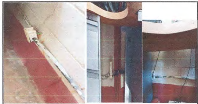
Foto 6: Reparación de sistema eléctrico los cables y accesorios po estar en mal estado, instalación con nuevos maaterial sustitución y reparación
