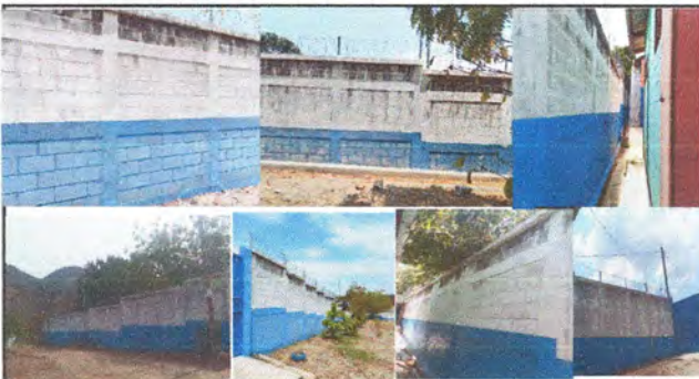
Foto 5: Pintura en muros exteriores e interiores se encuentra el color de las paredes deterioradas por tal motivo se deberá dar mantenimiento
