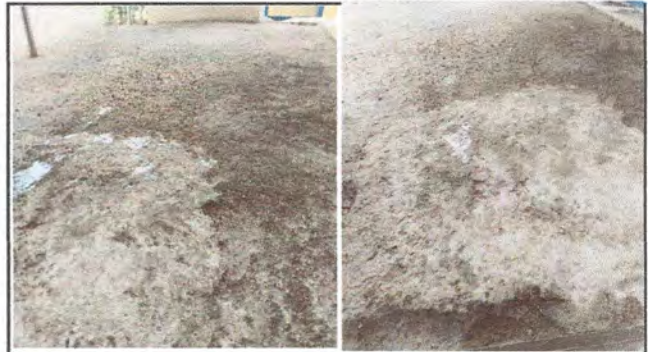
Foto 2: Piso Colocación de piso de torta de concreto
