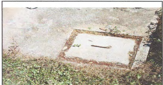
Foto 4: Reparación de drenaje y red de agua potable ,limpieza de fosa séptica
