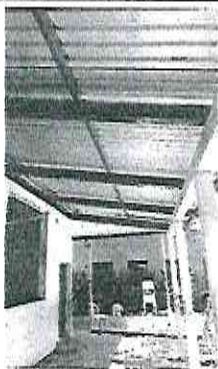
Foto 1: Desinstalación e instalación de lamina troquelada alizinc
