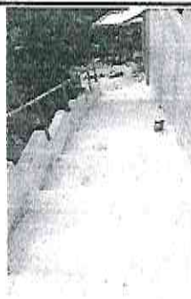
Foto 9: Sustitución de piso de torta de concreto en gradas con electromalla
