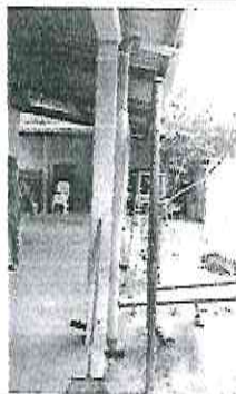
Foto 5: Sustitución de bajada de agua pluvial de metal por tubo PVC de 3"
