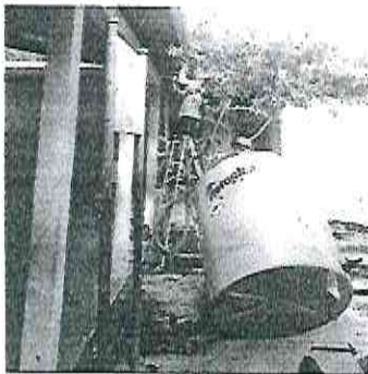
Foto 3: Sustitución de depósito de agua y sus accesorios
