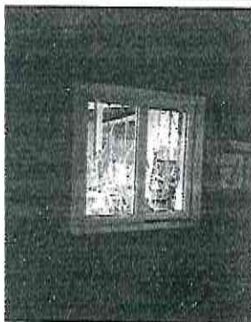
Foto7: Fabricación e instalación de ventanas tipo PVC. Mantenimiento a estructura de metal en ventana.
