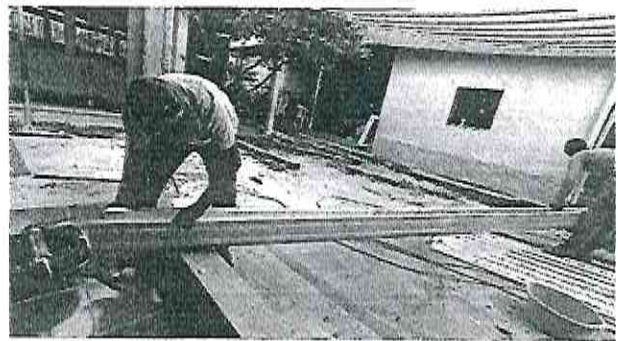
Foto 6: Instalación de canal de metal
