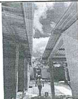
Foto 5: Sustitución de bajada de agua pluvial de metal por tubo PVC de 3"
