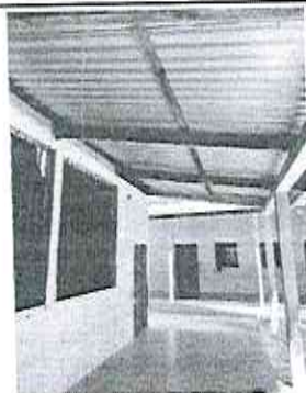
Foto 1: Desinstalación e instalación de lamina troquelada alizinc
