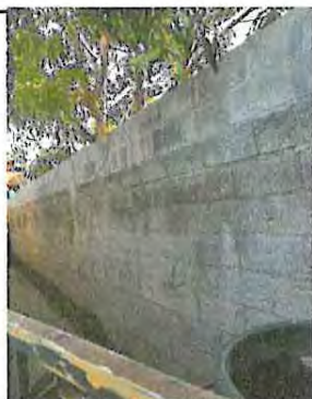
Foto 9: Cernido en muro perimetral de block de 90 M2
