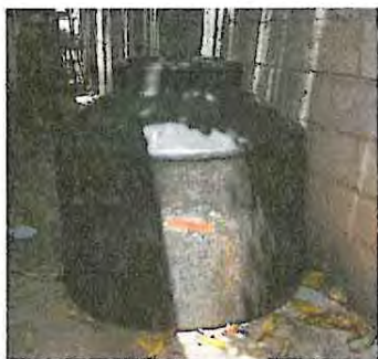
Foto 13: Sustrución de depósito de agua
