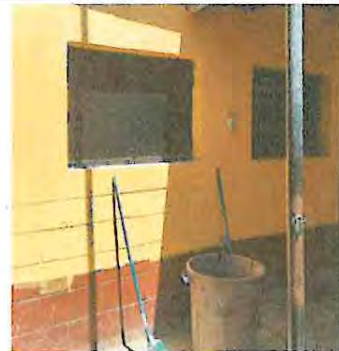
Foto 2: Fabricación e instalación de 2 balcones de hierro en ventanas, en el área de bodega
