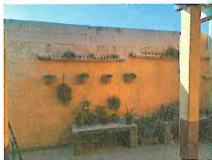
Foto 10: pintura en muro perimetral de 90 M2
