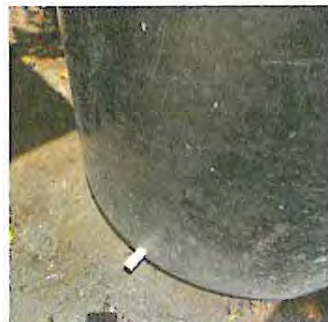
Foto 14: Sustrución de accesorios de depósito de agua
