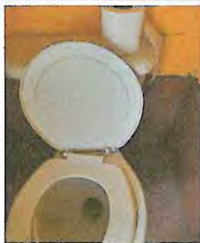
Foto 19: Sustitución de tapaderas de 3 sanitarios
