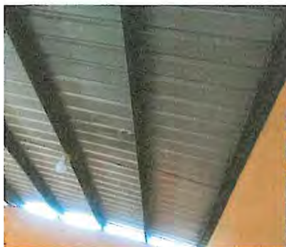
Foto 17: Sustrucción e instalación de lamina, por lámina troquelada aluzinc.
