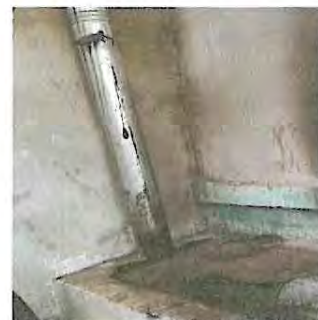
Foto 6: Sustrucción de chimenea de metal por chimenea de concreto
