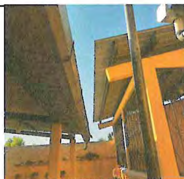
Foto 18: Instalación de canal de metal de 9 ML
