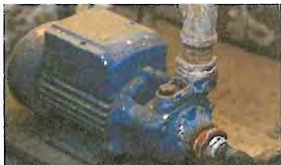
Foto 15: Sustrución de bomba de agua
