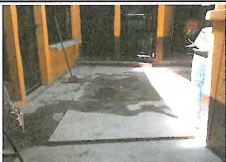
Foto 11: Sustitución de planchas de concreto en patio por piso cerámico para patio.
