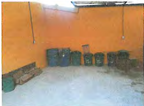
Foto 7: Instalación de mesita de concreto 2 m2
