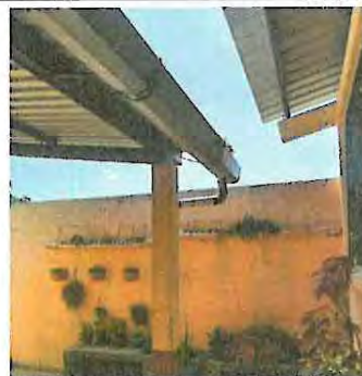
Foto 8: Instalación de alambre de seguridad en muro perimetral (30 ML)
