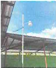
FOTO 6: Lámparas de poste instaladas
