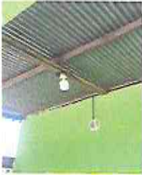
FOTO 9: Cambio de bombillos en salones, pasillos y galera, cocina y baños
