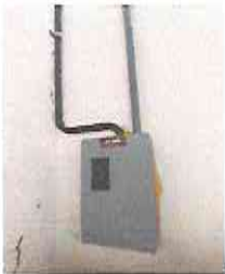
FOTO 7: instalacinón de flipon de cuatro cajas
