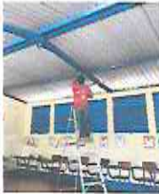
FOTO 4: cambio e instalación de ventiladores
