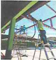
FOTO 5: cambio de estructura de techo
