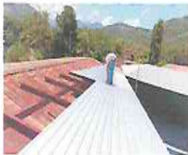
FOTO 6: cambio de lamina.
