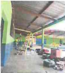
FOTO 7: cambio de manguera de cableado
