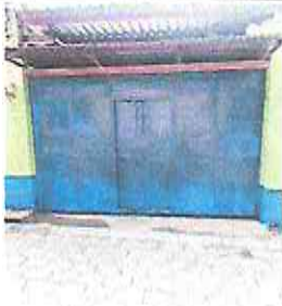
FOTO 10: Pintado de porton, para protegerlo de la humedad ya que la que tiene se encuentra en mal estado.
