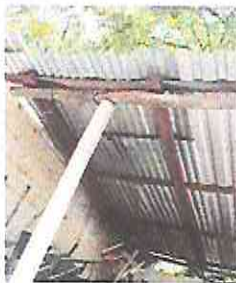
FOTO 7: sustitución de estructura de soporte de madera por metal y tubo estructural.
