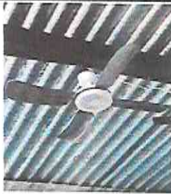
FOTO: sustitución de ventiladores de techo, ya que los que estan se encuentran dañados.
