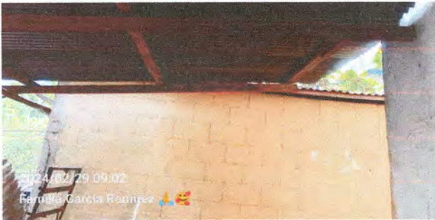
Foto 9: Sustitución de soporte de madera por metal
