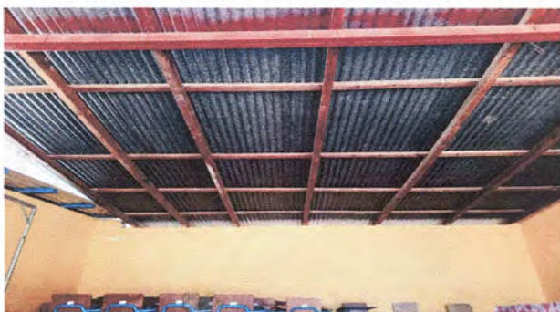
Foto1: Desinstalacion soporte de madera en area de escenario
