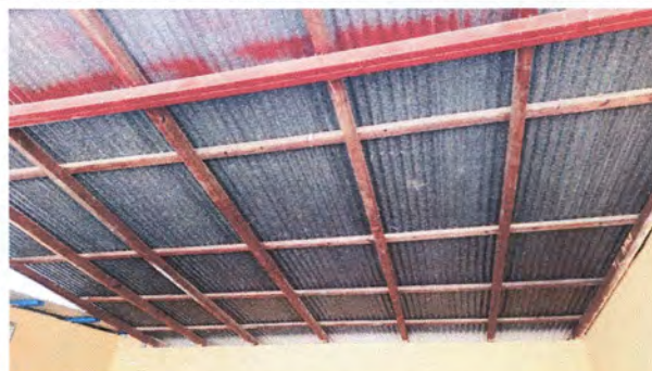
Foto2: Sustitucion de lamina por lamina troquelada
