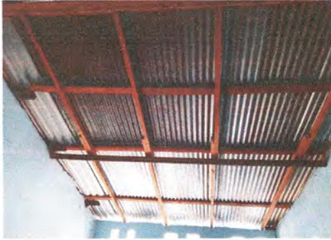
Foto 7: Sustitución de Lámina por lámina troquelada Aluzinc Cal. 26
