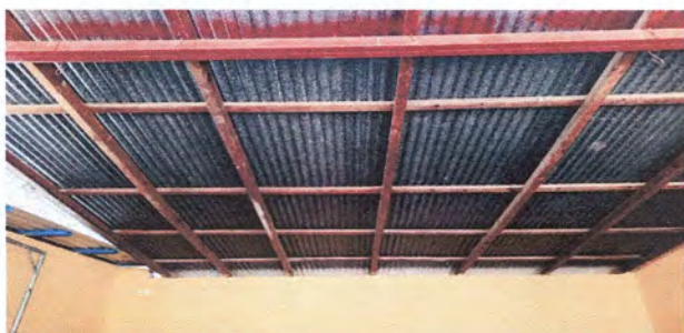
Foto 3: Instalación de soporte de metal
