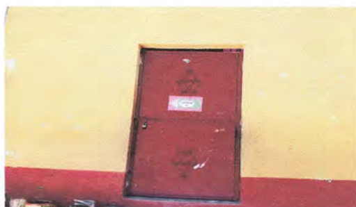
Foto 5: sustitucion de puerta de metal de 1.90x0.80 MTS
