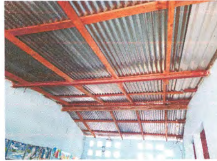
Foto 8: Instalación de soporte de metal
