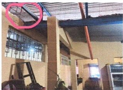
Foto 3. Desinstalación de estructura de metal para ampliar mojinete y reinstalarla nuevamente.
