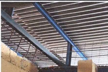
Foto 4. Desinstalación de lámina existente e instalación de la mina acanalada en aula.
