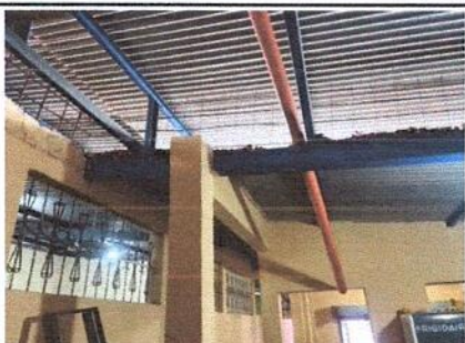
Foto 1. Desinstalación de lámina existente e instalación de lámina acanalada
