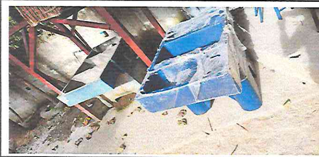
Foto 5: 3.1 SUSTITUCION DE PILA DE CONCRETO POR PILA PLASTICA DE DOS LAVADORES.
