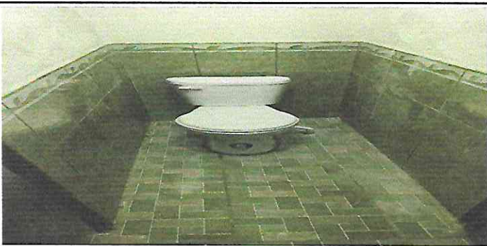
Foto 7: 4.2 SUSTITUCION DE SANITARIO DE PORCELANA.
