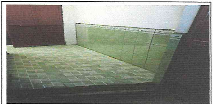
Foto 10: 4.5 REPELLO Y CERNIDO EN PAREDES DE BAÑOS
