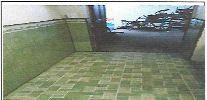
Foto 8: 4.3 SUSTITUCION DE PISO DE CONCRETO POR PISO CERAMICO
