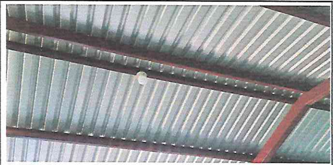
Foto 2: 1.2 INSTALACION DE CABLEADO DE ENERGIA ELECTRICA EN AULA
