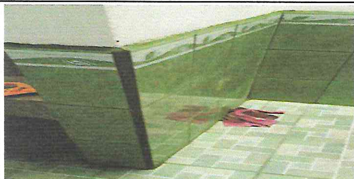
Foto 9: 4.4 INSTALACION DE AZULEJO EN PAREDES DE BAÑO
