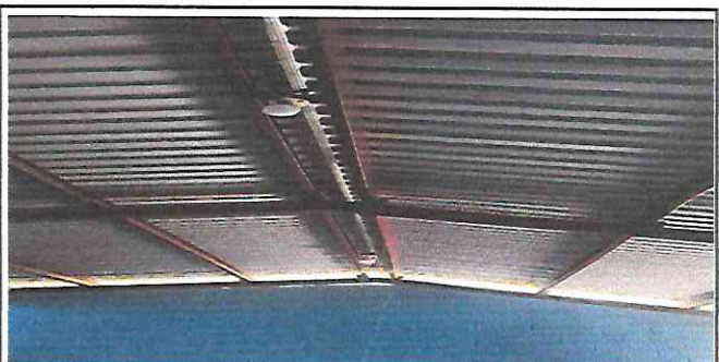
Foto 4: 2.2 INSTALACION DE CABLEADO DE ENERGIA ELECTRICA EN CORREDOR.
