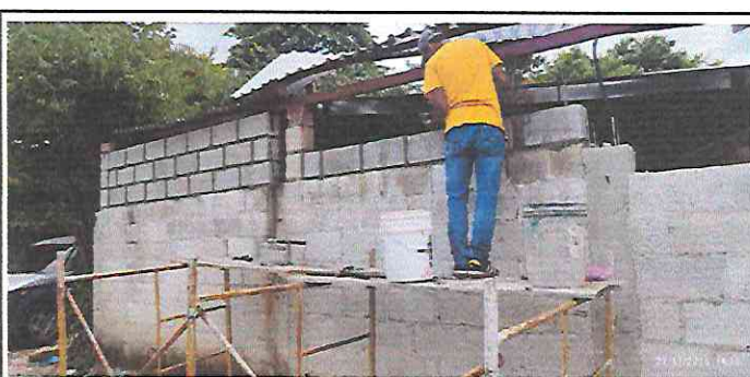
Foto 12: 5.2 REPELLO Y CERNIDO E IMPERMEABILIZACION EN PARED DE PATIO
