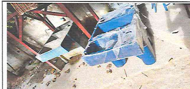
Foto 5: 3.1 SUSTITUCION DE PILA DE CONCRETO POR PILA PLASTICA DE DOS LAVADORES
