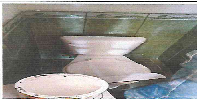
Foto 7: 4.2 SUSTITUCION DE SANITARIO DE PORCELANA.
