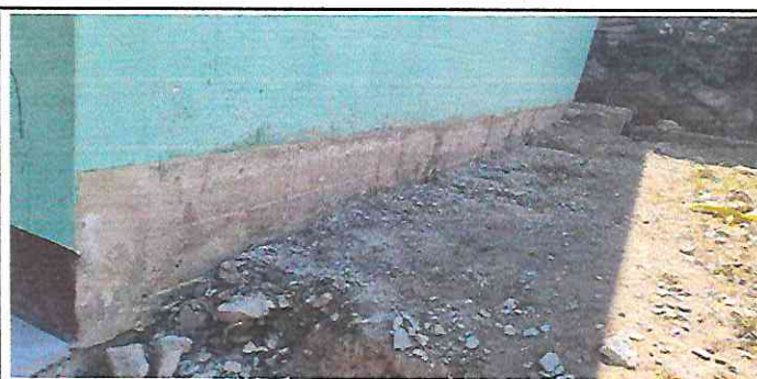
Foto 11: 5.1 DEMOLICION DE BANQUETA DE CEMENTO.
