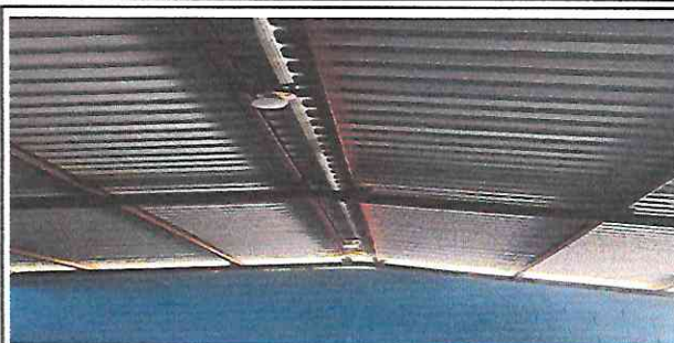
Foto 2: 1.2 INSTALACION DE CABLEADO DE ENERGIA ELECTRICA EN AULAS
