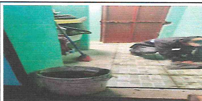
Foto 10: 4.5 REPELLO Y CERNIDO EN PAREDES DE BAÑOS
