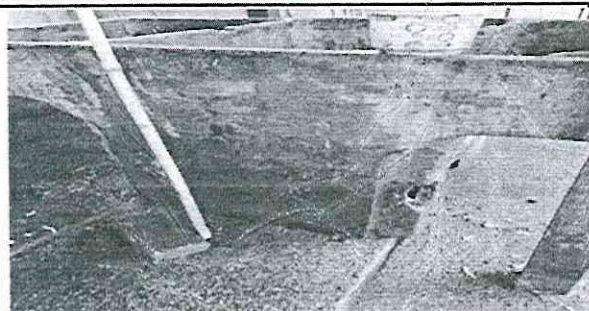
Foto 7 3.1 sustrucción de pila de concreto por pila plástica de dos lavaderos
