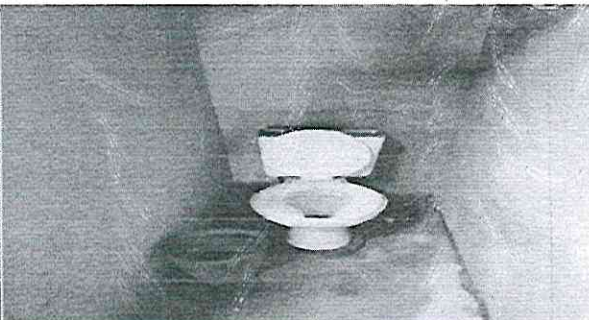
Foto 9 4.2 sustrucción de sanitario de porcelana
