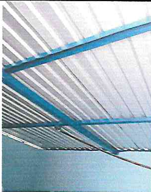
Foto 9: sustitución de lamina por lamina troquelada de cocina
