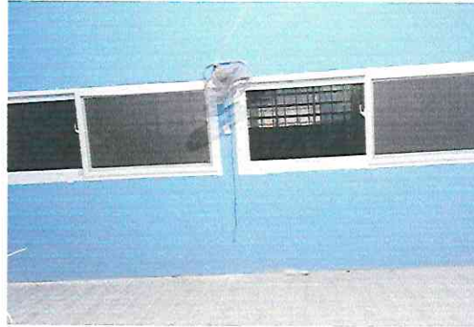
Foto 7: Instalación de ventanas PVC en aula
