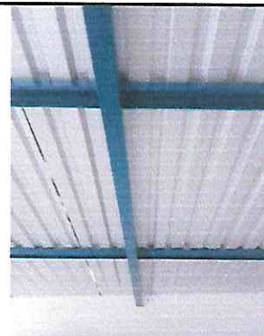
Foto 10: sustitución de estructura de soporte de metal de cocina
