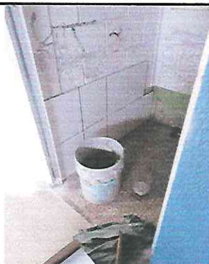
Foto 21: Suministro e instalación de azulejos en baños
