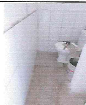
Foto 20: Suministro e instalación de piso mate en baños
