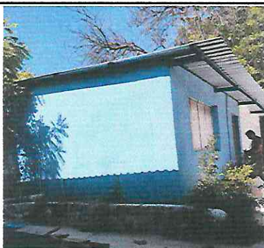
Foto 17: pintura en muros exteriores de cocina
