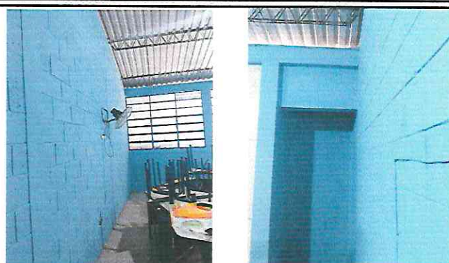
Foto 2: Pintura en Muros en Aula
