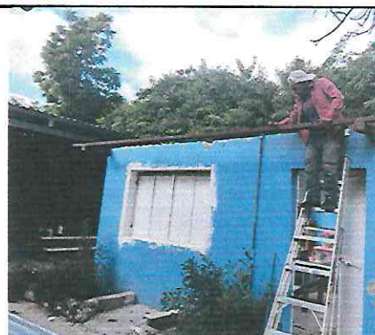
Foto 10. sustitucion de estructura de soporte de metal de cocina
