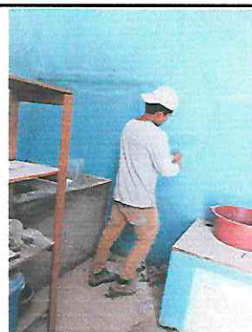
Foto 16: pintura en muros interiores de cocina
