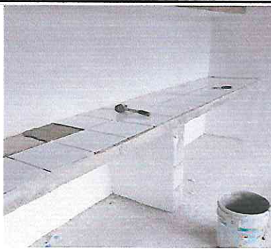
Foto 12. Instalación de azulejo en meson de concreto de cocina
