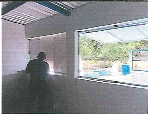
Foto 13: Instalación de ventana de metal
