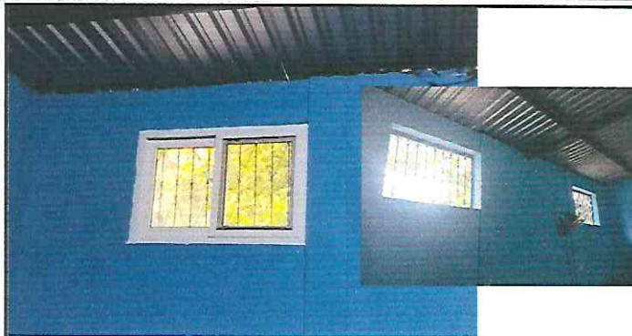
Foto 8: Instalación de ventanas PVC en aula
