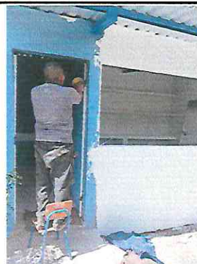
Foto 14: Instalación de puerta de metal en cocina
