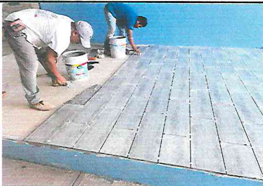
Foto 19: Suministro e instalación de piso mate en escenario
