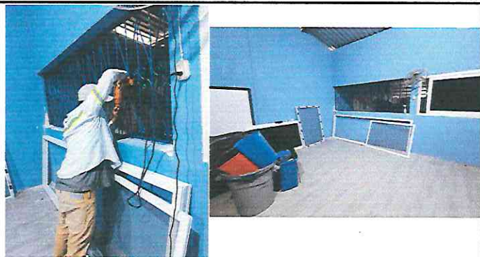
Foto 7: Instalación de ventanas PVC en aula
