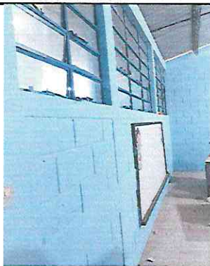
Foto 1: Pintura en Muros en Aula
