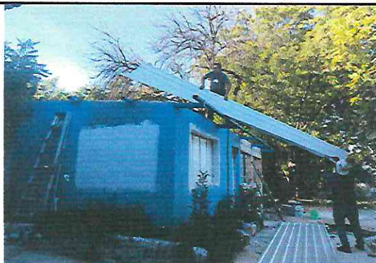
Foto 9. sustitucion de lamina por lamina troquelada de cocina
