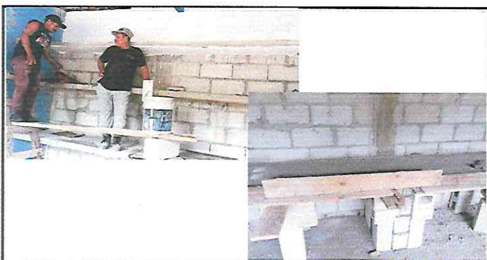
Foto 11: Suministro e instalación de gabinete de concreto en cocina
