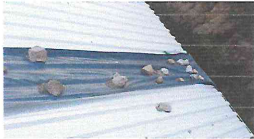
Foto 7: Sustitución de lámina troquelada aluzinc con tornillera de fijación.
