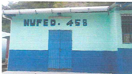
Foto 4: apertura de agujeros y tallado de vano para intalacion de 2 ventanas por falta de ventilación
