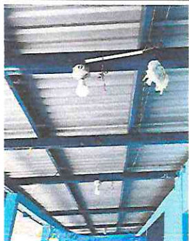
Foto 1: Sustrucción de cableado eléctrico, incluye mano de obra.
