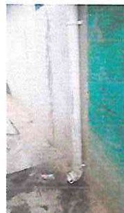
Foto 16: Sustrucción de tubería principal aguas pluviales
