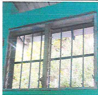
Foto 6: Sustrucción de vidrio de ventana de 1.40x90
