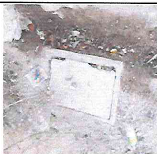
Foto 17: Sustrucción de 2 cajas de registro.
