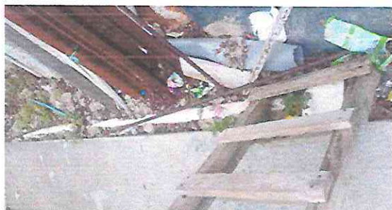
Foto 15: Sustrucción de tubería pvc línea principal aguas negras
