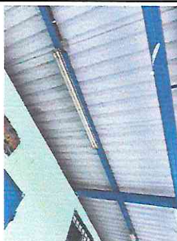
Foto 2: Sustrucción de lámparas tipo Led, ahorradoras, incluye instalación y materiales.
