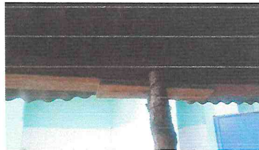
Foto 10: Instalación de estructura portante de metal
