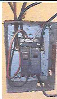
Foto 3: Sustrucción de tablero de 4 flipones, incluye flipones
