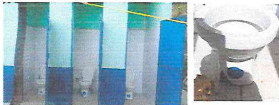
Foto 11: Sustitución de 3 inodoros más accesorios (contrallave, tubo de abasto y tanque)
