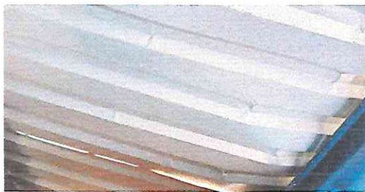
Foto 9: Sustitución de lámina por lámina troquelada aluzinc
