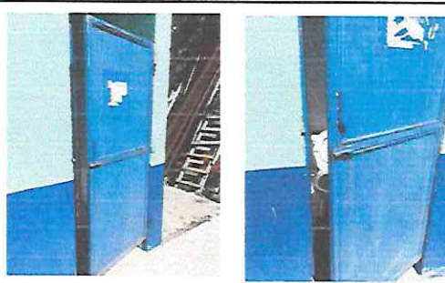
Foto 14: Mantenimiento a estructuras de puertas de metal. Lijado, cepillado y aplicación de pintura. Cambio de pasadores a ambos lados y bisagras ya que se traban.
