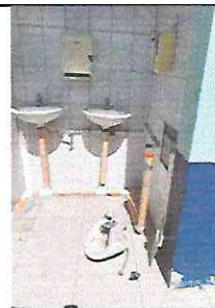
Foto 12: Sustitución de 2 lavamanos
