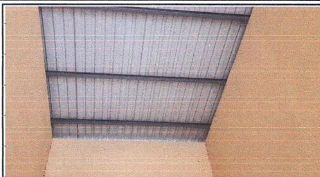
Foto 2: Sustrucción de lámina, por lámina troquelada aluzinc troquelada calibre 26
