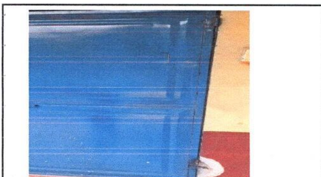
Foto 4: Mantenimiento en puerta de centro de computación
