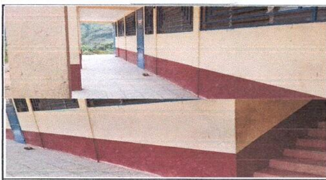
Foto 6: Pintura en muros exteriores e interiores.
