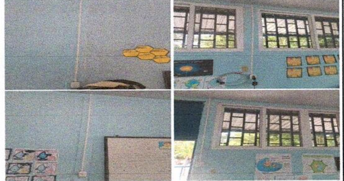
Foto 14: Sustrucción de ducto electrico mas accesorios (Renglón de trabajo 8.4.)
