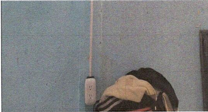
Foto 13: Sustrucción de tomacorrientes dobles (Renglón de trabajo 8.3.)
