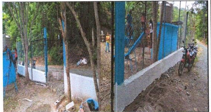
Foto 16: Repello con cernido de (Repello de muro con cernido)
