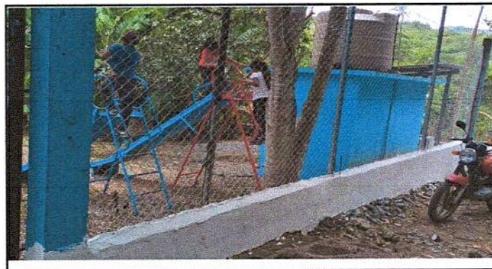
Foto 10: Reparación de tubo hg y Malla Galvanizada (Renglón de trabajo 7.3.)
