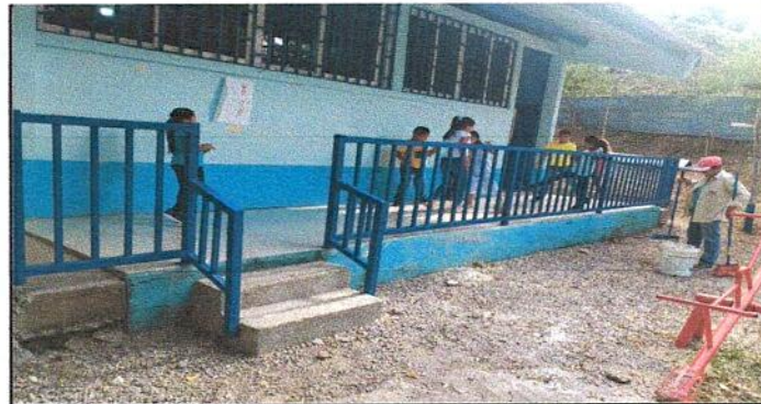
Foto 6: Fabricación e instalación de barandal de tubo de 3/4 (Renglón de trabajo 5.1.)
