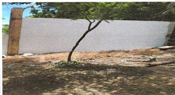
Foto 9: Reparación de muro perimetra (Renglón de trabajo 7.2.)
