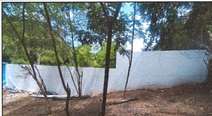
Foto8: Levantamiento de 3 hiladas de blocks ( Renglón de trabajo No.7.1.)
