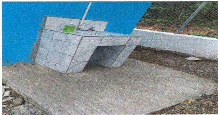
Foto 5: Fabricación e instalación de lavamanos de concreto y accesorios (Renglón de trabajo 4.2.)
