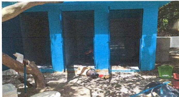
Foto 4: Sustitución de inodoros Marca Corona (Renglón de trabajo 4.1.)
