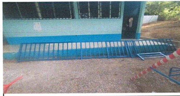
Foto 6: Fabricación e instalación de barandal de tubo de 3/4 (Renglón de trabajo 5.1.)
