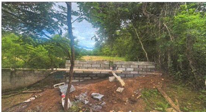
Foto 9: Reparación de muro perimetra (Renglón de trabajo 7.2.)
