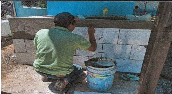
Foto7: Instalación de azulejos en la pila (Renglón de trabajo No. 6.1.)
