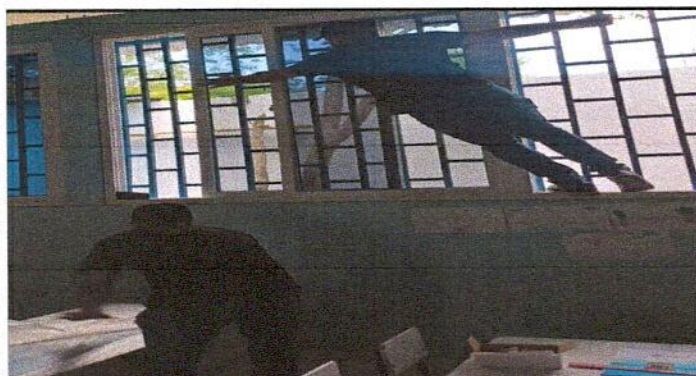
Foto 3: Mantenimiento e instalación de ventanas PVC (Renglón de trabajo 3.1.)
