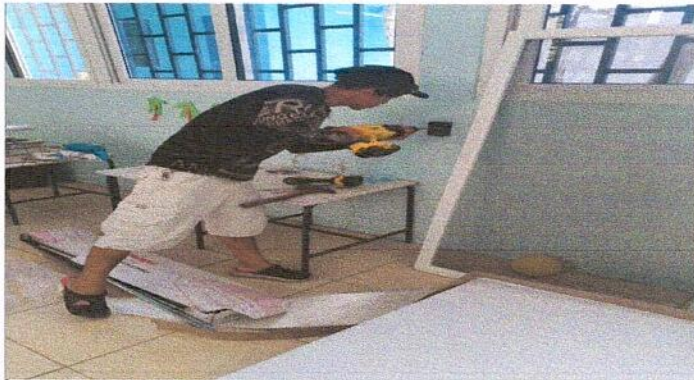
Foto 13: Sustitución de tomacorrientes dobles (Renglón de trabajo 8.3.)
