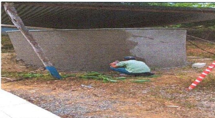
Foto 15: Reparación y repello de cisterna (Renglón de trabajo 9.1.)
