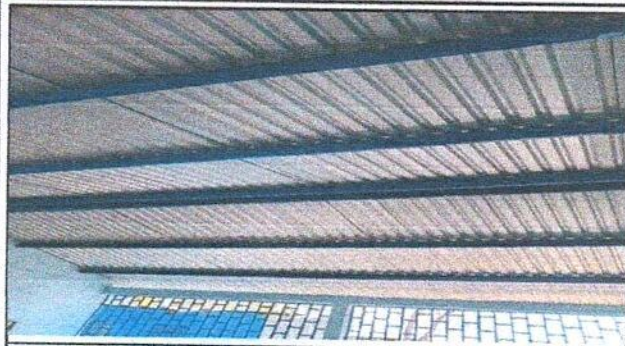
Foto 13: Sustitución de plafoneras (Renglón detrabajo No.8.2)
