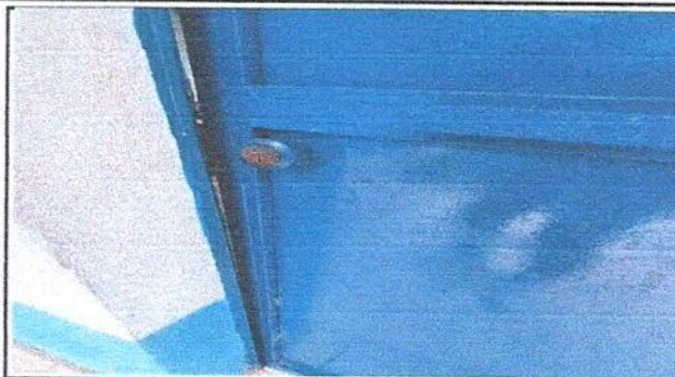
Foto 2: Sustitución de chapa Marca (Renglón de trabajo No.2.1)
