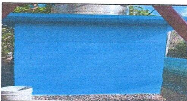
Foto 5: Fabricación e instalación de lavamanos de concreto con accesorios (Renglón de trabajo No.4.2)
