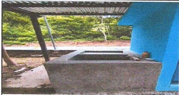
Foto 7: Instalación de azulejo en la pila (Renglón de trabajo No.6.1)
