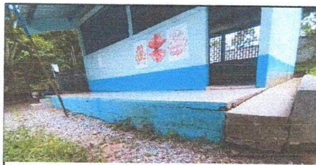
Foto6: Fabricación e instalación de barandal de tubo de 3/4 (Renglón de trabajo No.5.1)
