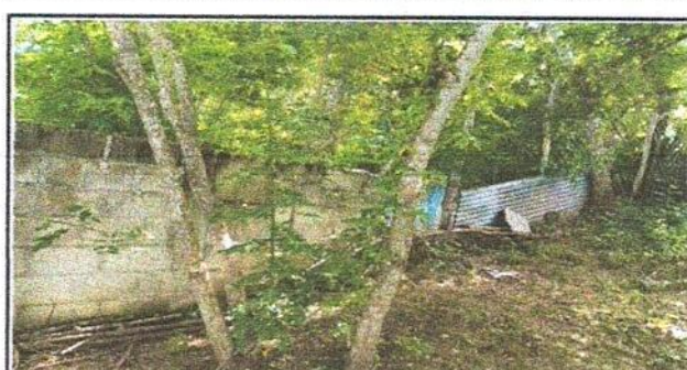
Foto 10: Ampliación de muro perimetral (Renglón de trabajo No.7.2)
