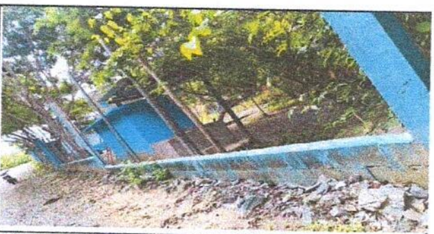
Foto 17: Repello de muro con cernido. (Renglón detrabajo No.10.1)
