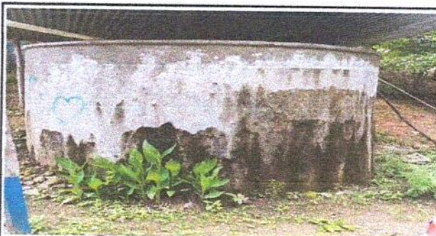
Foto 16: Reparación y repello de Cisterna. (Renglón detrabajo No.9.1)
