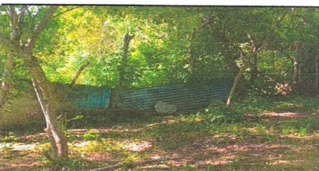
Foto 9: Ampliación de muro perimetral (Renglón de trabajo No.7.2)
