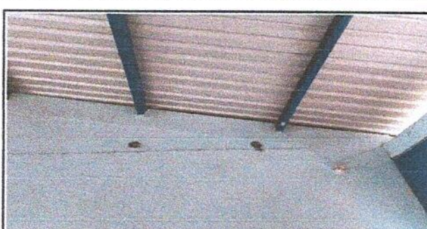
Foto 12: Sustitución de bombillas de 45 Wts (Renglón de trabajo No.8.1)
