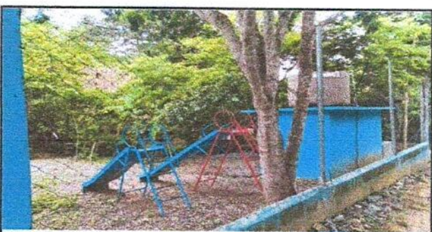
Foto 11: Reparación de tubo hg y Malla Galvanizada (Renglón de trabajo No.7.3)
