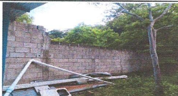
Foto 8: Levantamiento de 3 hiladas de bloks (Renglón de trabajo No.7.1)
