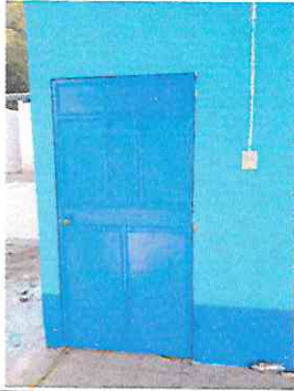
Foto 19: Mantenimiento a puertas de metal (Lijado, cambio de tubo, cepillado y aplicación de pintura) de 1,5 mts2 cada una.
