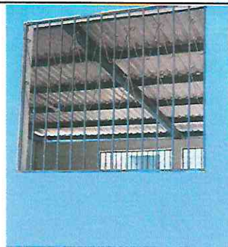
Foto 10: Sustitución e instalación de balcón de metal 3.48 mts de ancho x 1.58 mts de alto
