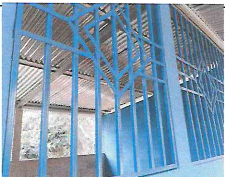
Foto 11: Sustitución e instalación de balcón de metal 8.48 mts de ancho x 1.16 mts de alto
