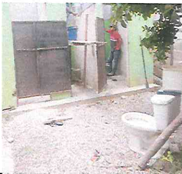
Foto 17: Sustrucción de inodoros
