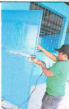
Foto 19: Mantenimiento a puertas de metal (Lijado, cambio de tubo, cepillado y aplicación de pintura) de 1,5 mts2 cada una.
