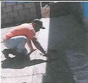
Foto 5: Sustitución de Cuneta de Concreto
