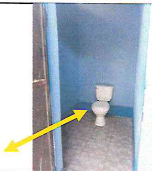
Foto 17: Sustitución de inodoros
