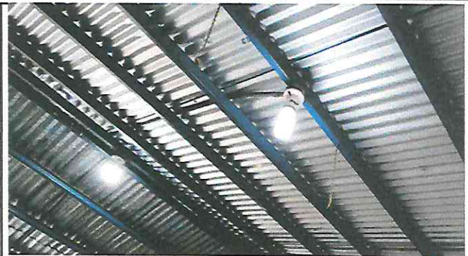
Foto 14: Sustrucción de plafonera, cajas exagonales y bombillas led
