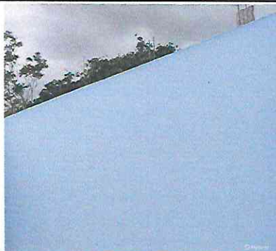
Foto1: Foto 1: Reparación de Muro de Block (Subirle al muro 3 hiladas de block)
