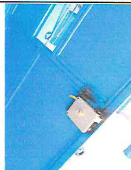
Foto 12: Sustitución de chapa Yale en puerta
