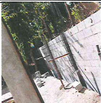
Foto 1: Reparación de Muro de Block (Subirle al muro 3 hiladas de block)
