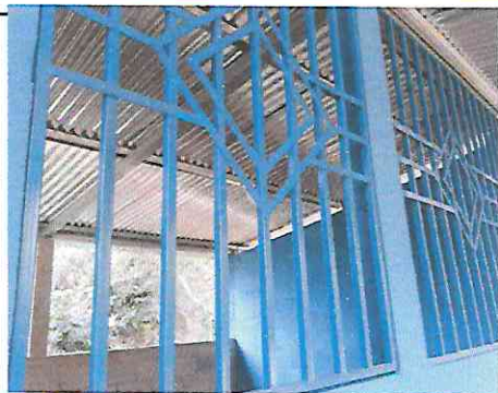
Foto 9: Sustitución e instalación de balcón de metal 2.88 mts de ancho 1.16 mts de alto
