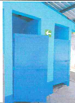
Foto 8: Pintura en Muros Interiores y Exteriores
