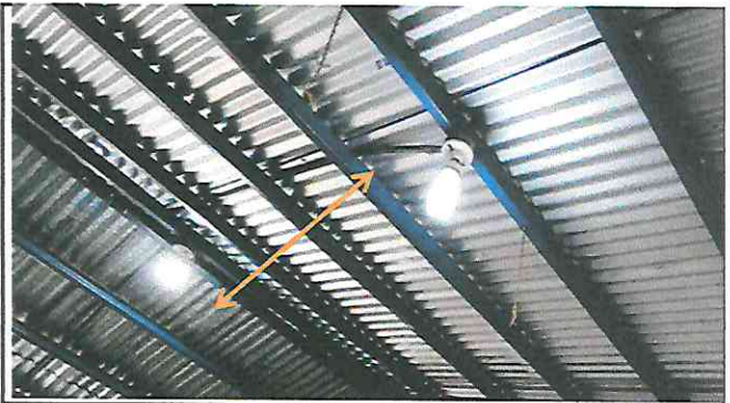
Foto 16: Instalación de flexitubo
