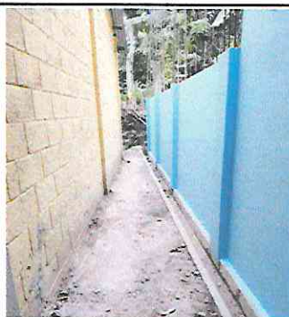
Foto 2: Aplicación de Repellos
