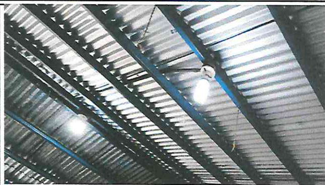
Foto 14: Sustitución de plafonera, cajas exagonales y bombillas led
