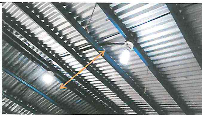
Foto 16: Instalación de flexitubo
