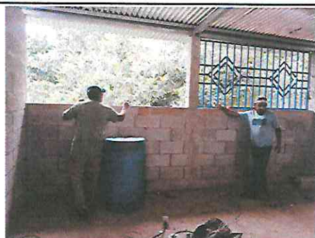
Foto 11: Sustitución e instalación de balcón de metal 8.48 mts de ancho x 1.16 mts de alto
