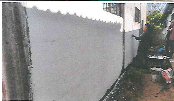
Foto 6: Aplicación de Repellos
