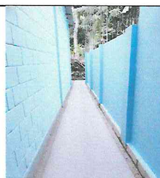
Foto 2: Aplicación de Repellos
