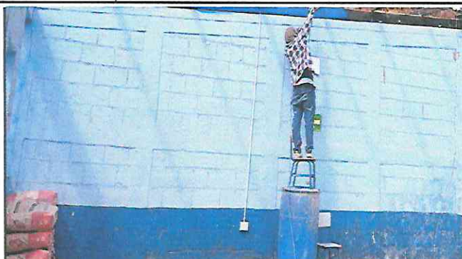
Foto 8: Pintura en Muros Interiores y Exteriores
