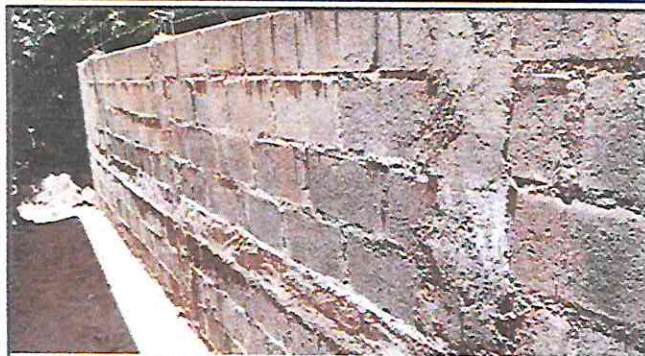
Foto 1: Reparación de Muro de Block (Subirle al muro 3 hiladas de block)
