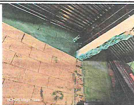
Foto 8: Pintura en Muros Interiores y Exteriores
