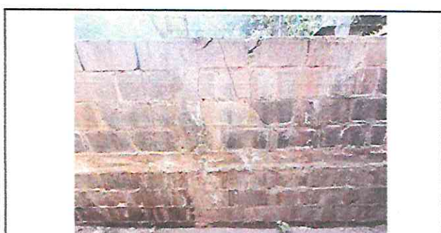
Foto 4: Pintura en Muro
