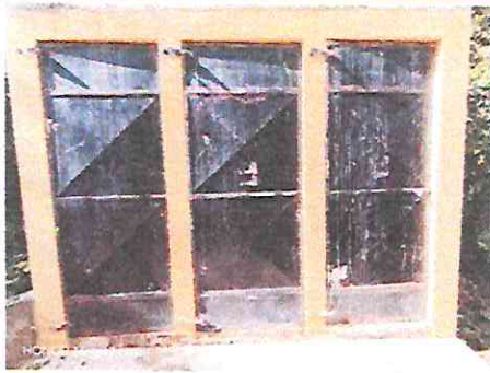
Foto 17: Mantenimiento a puertas de metal (Lijado, cambio de tubo, cepillado y aplicación de pintura) de 1,5 mts2 cada una.
