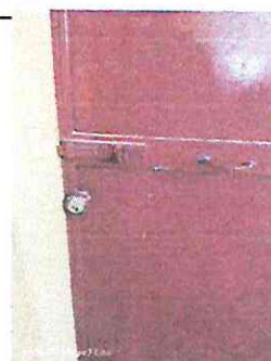
Foto 12: Sustitución de chapa Yale en puerta
