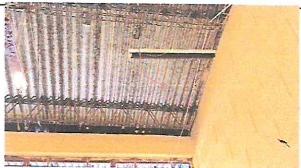
Foto 14: Instalación de flexitubo
