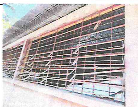
Foto 10: Sustitución e instalación de balcón de metal 3.48 mts de ancho x 1.58 mts de alto
