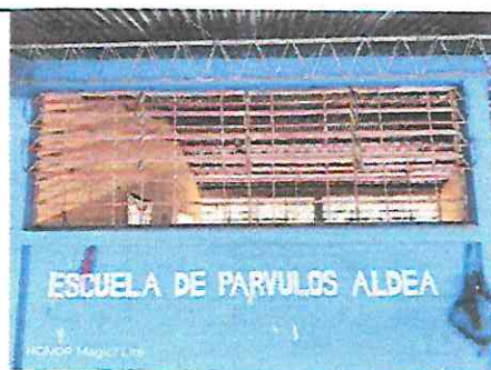
Foto 11: Sustitución e instalación de balcón de metal 3.48 mts de ancho x 1.16 mts de alto
