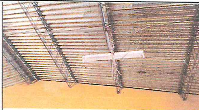
Foto 13: Sustitución de cableado eléctrico incluye fase y neutro
