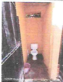
Foto 15: Sustitución de inodoros
