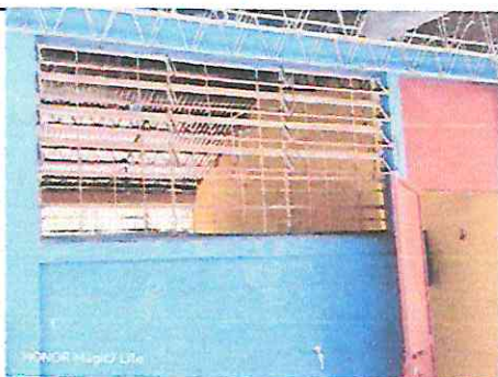
Foto 9: Sustitución e instalación de balcón de metal 2.88 mts de ancho x 1.16 mts de alto
