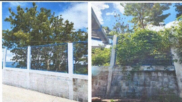
Foto 7: Sustitución de malla galvanizada por hiladas de block en muro de contención
