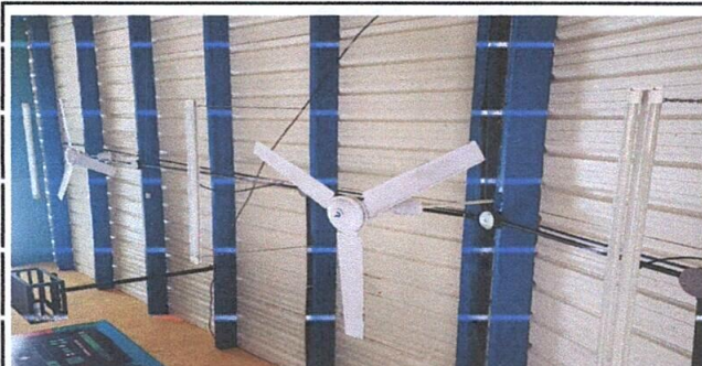
Foto 6: Sustitución de lámpara por bombillas led y plafoneras en salón de clases
