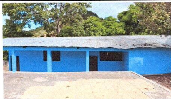
Foto 6: MUROS EXTERIORES PINTADOS REMOZADOS
