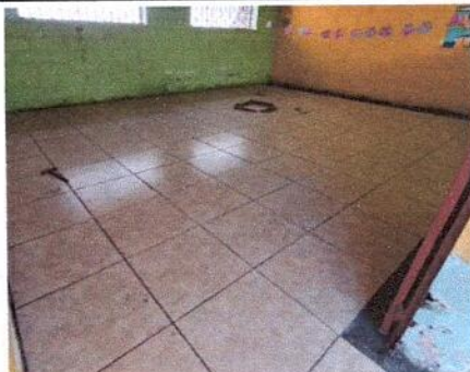
Foto 5: PISO CERAMICO EN AULAS REMOZADO
