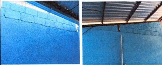
Foto 5: MURO DE COCINA REMOZADO
