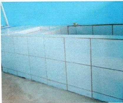
Foto 3: PILA DE CONCRETO FINALIZADA
