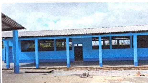
Foto 4: MUROS EXTERIORES PINTADOS REMOZADOS
