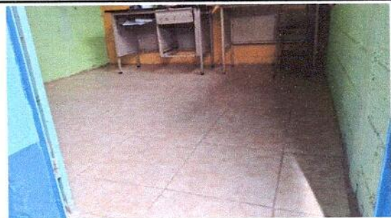
Foto 6: PISO EN AULAS REMOZADO
