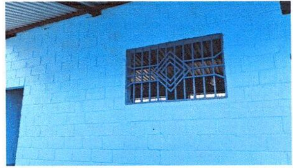
Foto 2: PINTURA A BALCONES REMOZADO
