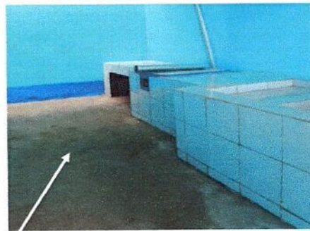
Foto 4: PISO DE CONCRETO EN COCINA FINALIZADA
