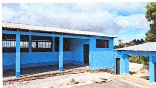
Foto 5: MUROS EXTERIORES PINTADOS REMOZADOS
