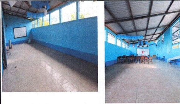
Foto1: PISO EN AULAS REMOZADO
