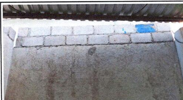
Foto 5: REPARACION DE MURO EN COCINA (sellado de agujero en pared y levantado de hiladas de block)
