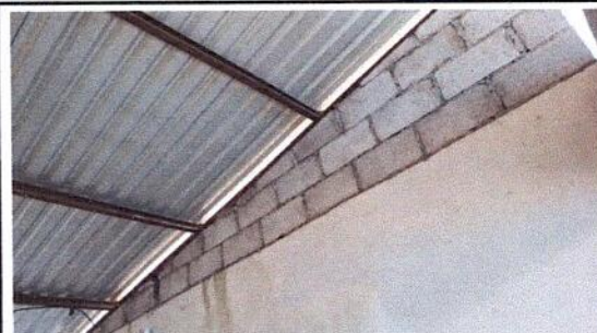
Foto 6: REPARACION DE MURO EN COCINA (sellado de agujero en pared y levantado de hiladas de block)
