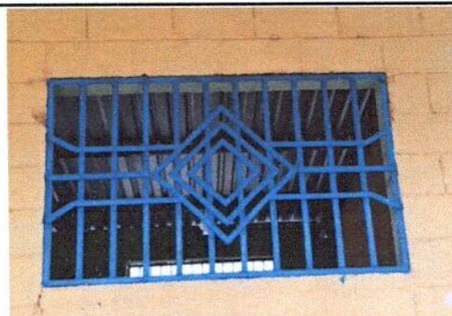
Foto 4: MANTENIMIENTO Y PINTURA A BALCONES
