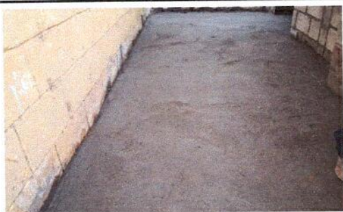
Foto 5: REMOZAMIENTO DE PISO DE CONCRETO EN COCINA
