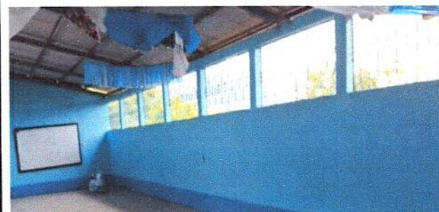
Foto 2: MANTENIMIENTO Y PINTURA A BALCONES
