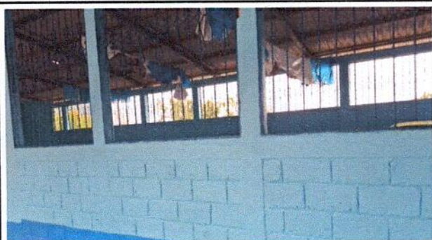
Foto 3: MANTENIMIENTO Y PINTURA A BALCONES
