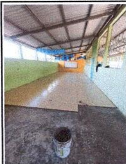
Foto 1: INSTALACION DE PISO CERAMICO EN AULAS
