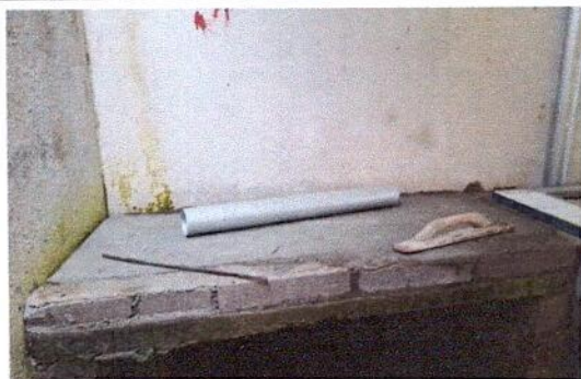
Foto 1: INSTALACION DE AZULEJO EN MESA DE TRABAJO
