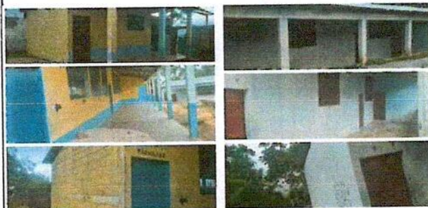
Foto 16: pintura en muro exteriores
