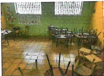
Foto 5: instalación de piso ceramico en aulas
