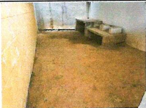
Foto1: Instalación de Azulejo en mesa de trabajo
