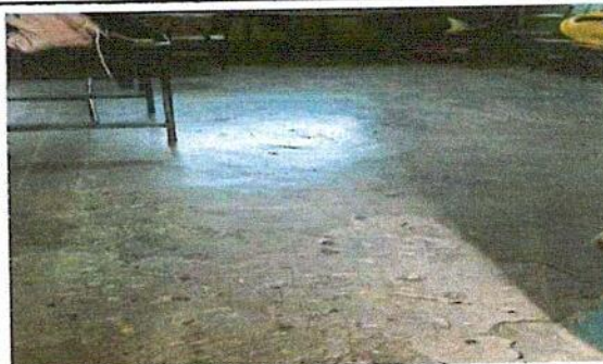
Foto 6: instalación de piso ceramico en aulas
