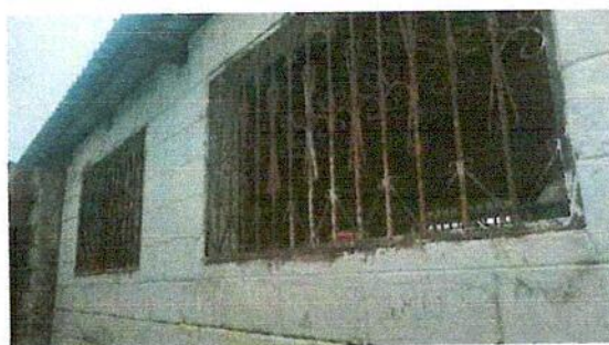
Foto 10: Mantenimiento y pintura a balcones
