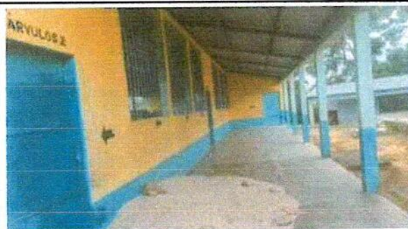
Foto 8: Mantenimiento y pintura a balcones
