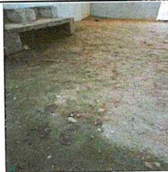
Foto 4: sustitución de piso de torta de concreto en cocina
