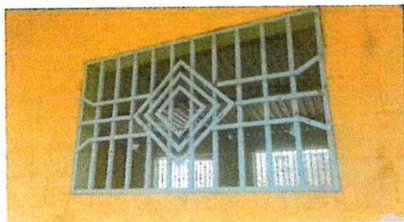
Foto 9: Mantenimiento y pintura a balcones
