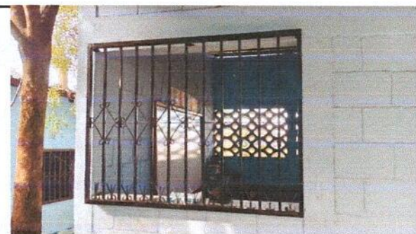
Foto 3: Sustrucción de Balcones de metal
