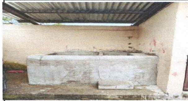
Foto 8: Sustrucción de pila de cemento de 1 lavadero.
