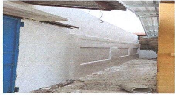
Foto 10: Repello en muro de ingreso de la entrada principal.
