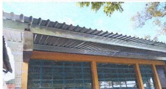
Foto 2: Sustrucción de Estructura de metal por metal
