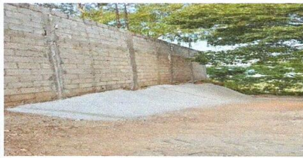
Foto 9: Reparación de muro perimetral de block
