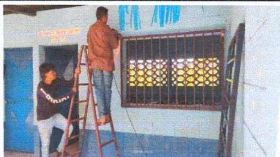
Sustitución de Balcones de metal
