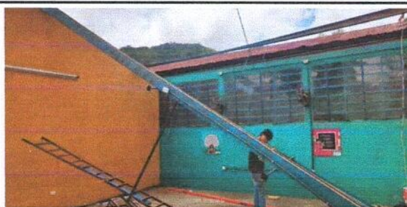
Foto 2: Sustitución de Estructura de metal por metal
