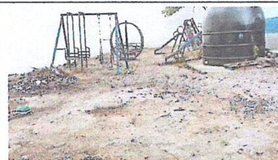
Foto 4: Sustrución de piso de torta de concreto en área de juegos
