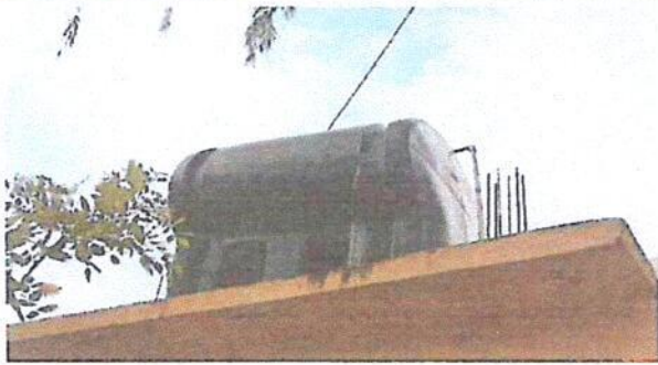
Foto 7: Sustitución de rotoplas de 1200 lt
