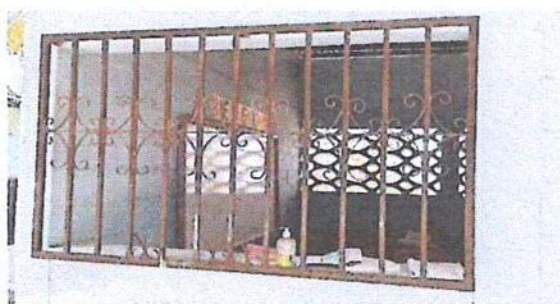
Foto 3: Sustrución de Balcones de metal
