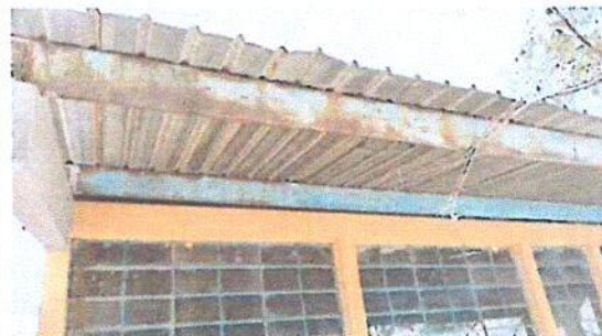
Foto 2: Sustrución de Estructura de metal por metal
