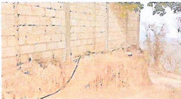
Foto 9: Reparación de muro perimetral de block
