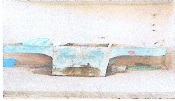
Foto 8: Sustitución de pila de cemento de 1 lavadero
