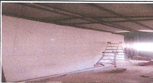
Foto1: POSTERIOR: División de tabla yeso en el área de cocina
