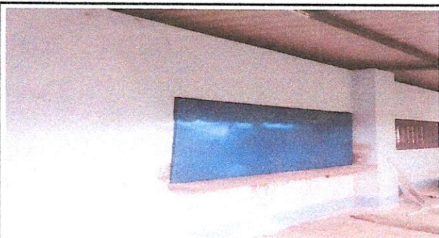
Foto 3: POSTERIOR: Instalación de ventana de metal en cocina
