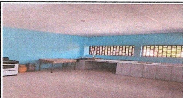
Foto 7: POSTERIOR: Instalación de pila en cocina
