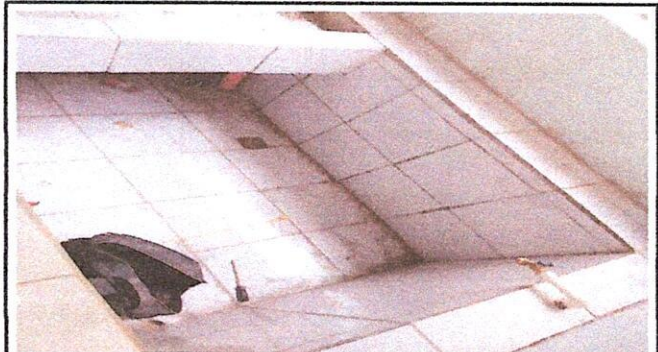
Foto 8: DURANTE: Instalación de azulejo en pila de cocina
