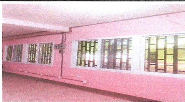
Foto 9: DURANTE: Fabricación e instalación de cuatro ventanas de persianas de pvc en centro de cómputo
