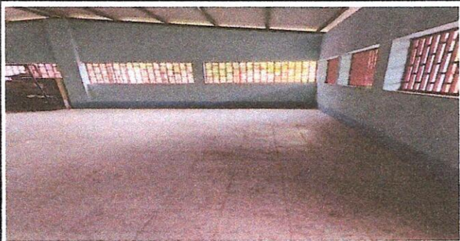
Foto1: ANTES Fabricación de una pila de oncreto de un lavadero
