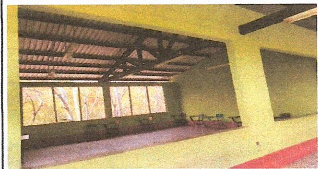
Foto 8: ANTES Fabricación e instalación de balcones de metal
