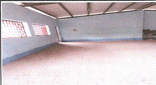
Foto 3: ANTES Reparación o sustitución de área de cocina, pila, ventanas.
