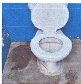
Foto 5:Sustitución de inodoro
