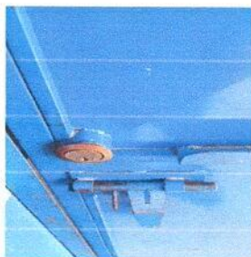
Foto1: Sustitución de chapa
