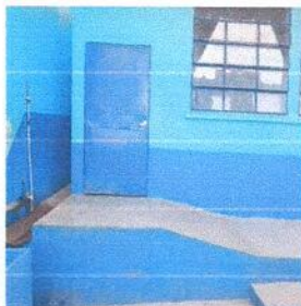
Foto 19: Suministro e instalación de baranda enfrente de aula
