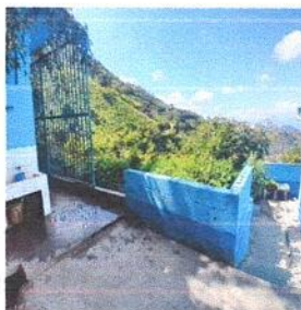
Foto 16: Suministro e instalación de barandas en muro.
