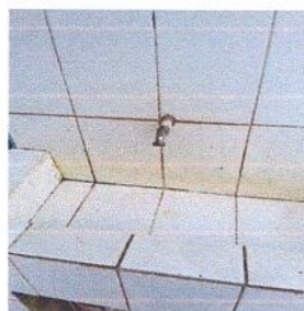
Foto 6: Sustitución de llave en lavamanos
