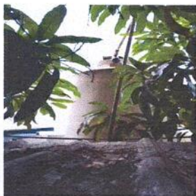
Foto 13: Instalación de agua potable de depósito de agua a la cocina
