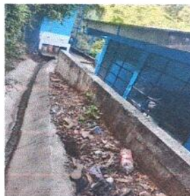
Foto 14: Fundición de torta de concreto en patio en la parte de atrás de la escuela área de baños.
