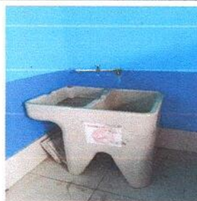
Foto 10: Sustitución de pila plástica de un lavadero por pila de concreto, Suministro e instalación de azulejo en pila de concreto.
