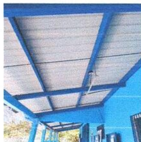
Foto 8: Sustitución de lámparas LED por bombillas LED, sustitución de cableado eléctrico y suministro e instalación de plafoneras.
