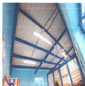
Foto 18: Suministro e instalación de cielo falso de pvc en aulas.
