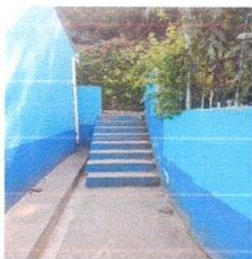
Foto 15: Suministro e instalación de barandas en gradas para subir a los baños.
