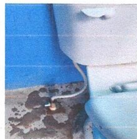
Foto 4: Sustitución de accesorios
