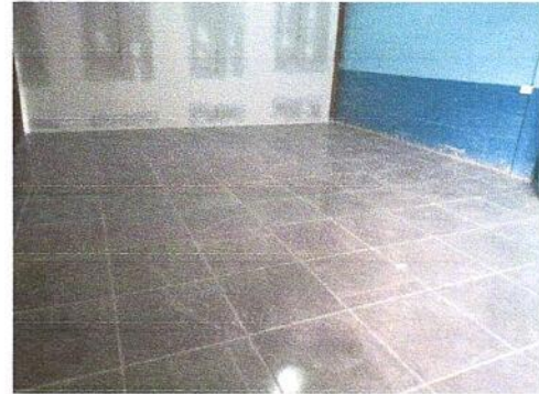
Foto 8: Instalación de piso cerámico en aula.
