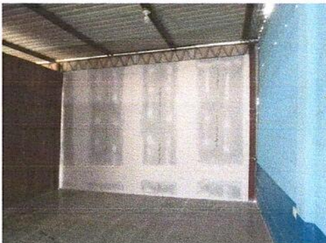
Foto 11: sustitución de lámina por tabla yeso Durock para exterior y aislante térmico doble cara
