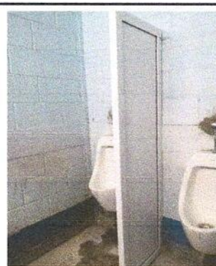
Foto 4: Instalación de migitorios y división de PVC en el área
