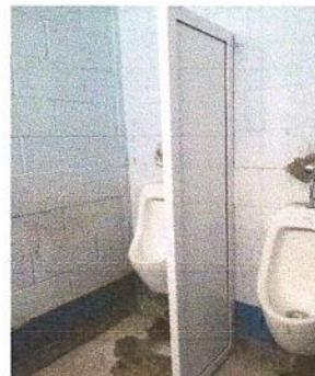
Foto 14: Instalación de división de PVC
