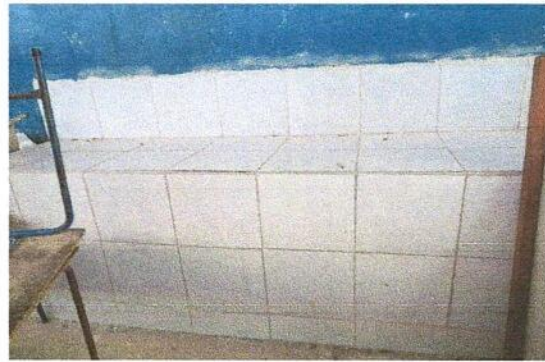
Foto 2: Instalación de torta de cemento y azulejo a mesa de trabajo
