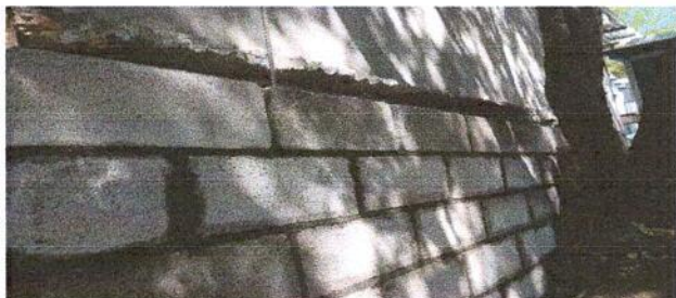
Foto 13: Levantamientos de hiladas de block
