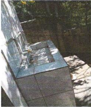
Foto 7: Sustitución de torta de cemento en lavamanos
