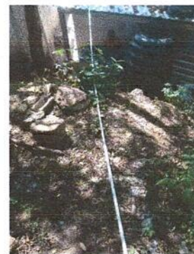
Foto 10: Sustitución de tubería para agua potable.
