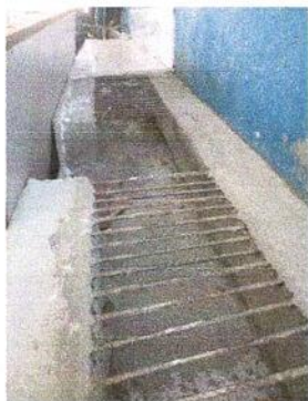
Foto1: Fabricación de polletón de concreto.
