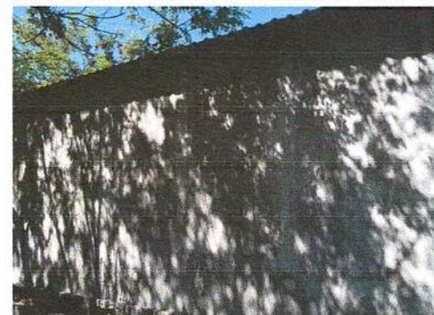
Foto 12: sustitución de lámina por tabla yeso Durock para exterior y aislante térmico doble cara
