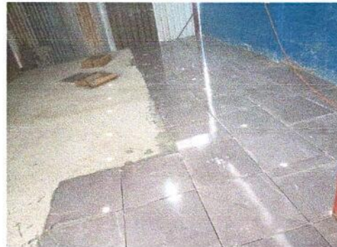
Foto 8: Instalación de piso cerámico en aula.
