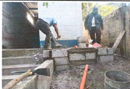
Foto 6: Sustitución de torta de cemento en lavamanos
