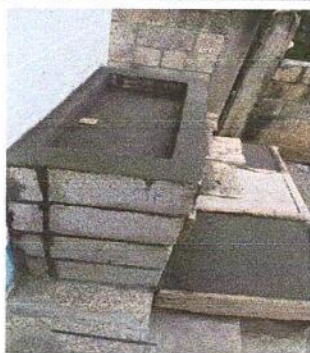
Foto 5: Fabricación de lavamanos de concreto
