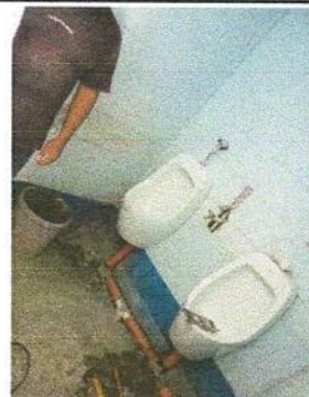
Foto 4: Instalación de migitorios y división de PVC en el área
