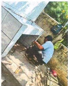
Foto 7: Sustitución de torta de cemento en lavamanos
