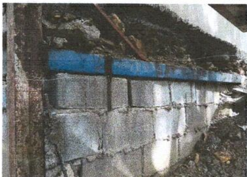
Foto 13: Levantamientos de hiladas de block
