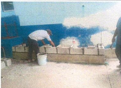
Foto1: Fabricación de polletón de concreto.
