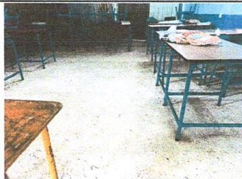
Foto 8: Instalación de piso cerámico en aula.
