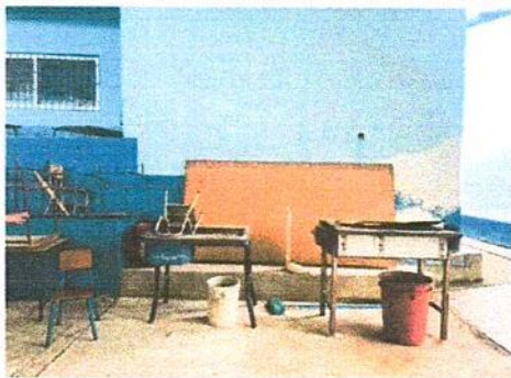
Foto 1: Fabricación de polletón de concreto.
