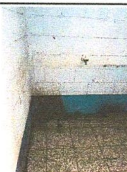
Foto 4: Instalación de migitorios.
