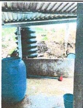
Foto 3: Sustitución de depósito de agua de 6,000 litros y suministro de bomba de agua.
