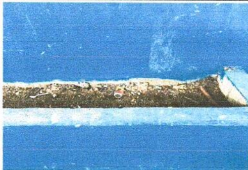
Foto 2: Instalación de torta de cemento y azulejo a mesa de trabajo
