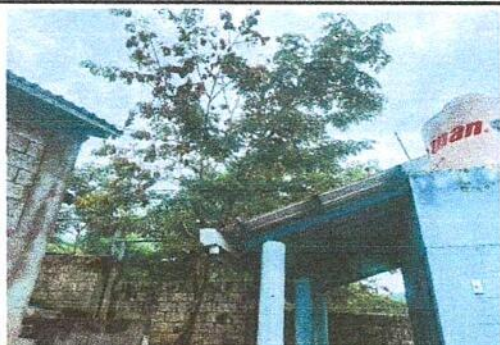
Foto 9: Instalación de tubería para agua potable línea principal
