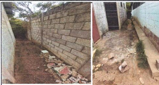
Foto 1: Instalación de planchas de concreto en patios.
