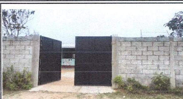
Foto 2: Reparación de estructura de metal en el portón de ingreso.
