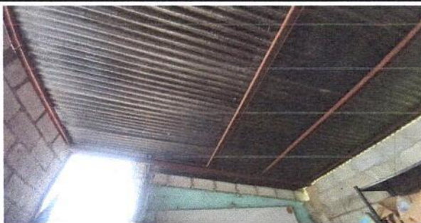
Foto 5: Sustitución de láminas por láminas troquelada calibre 26 legítima
