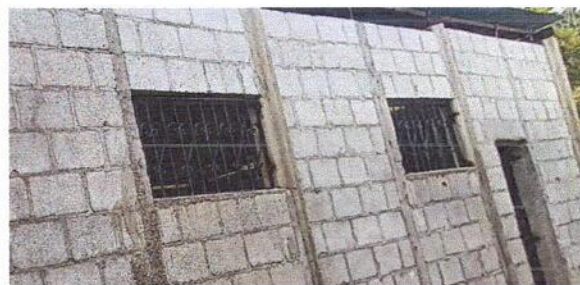
Foto 4: Instalación de ventana de pvc aula 1.
