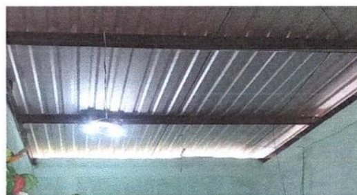
Foto 4: Sustitución de lámparas de tipo LED.
