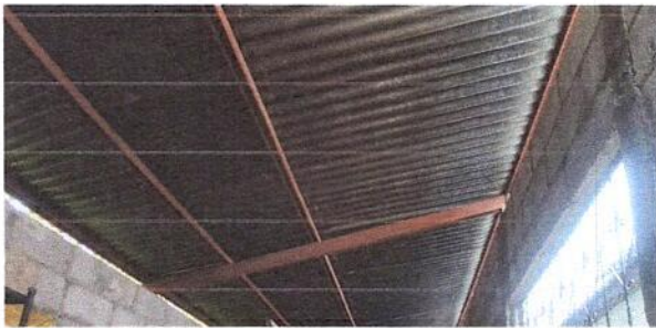
Foto1: Sustitución de estructura metálica.
