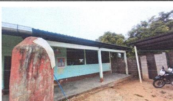
Foto 4: Sustitución de bajada de agua pluvial.
