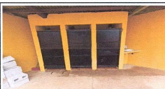
Foto 6: Mantenimiento de puertas por estar muy separadas de las planas (lijado y pintura).
