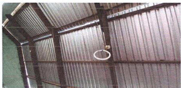
Foto 5: Sustitución de Plafoneras.
