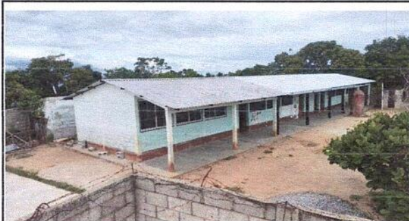
Foto 3: Aplicación de pintura en muros, interiores y exteriores de todas las aulas.
