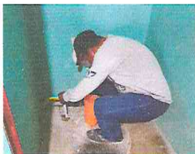
Foto 1: Sustitución de tubería PVC línea principal aguas negras en baños.
