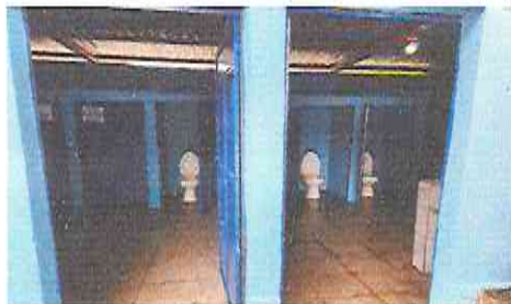
Foto 3: Sustitución de piso antideslizante en baños
