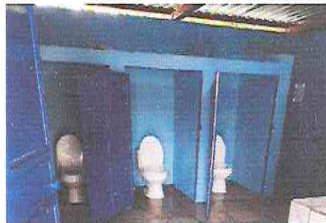
Foto 8: Sustitución e instalación de inodoros de una pieza marca Corona estilo Oporto Elogado en baños.
