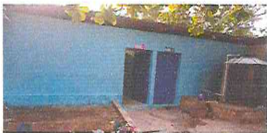
Foto 7: Pintura de muros interior y exterior de baños.
