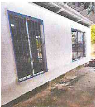
Foto 9: Instalación de balcón de metal en dirección.
