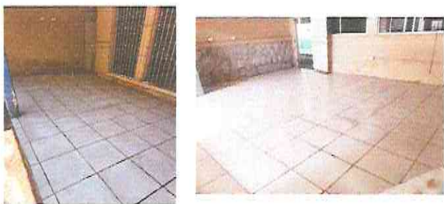
Foto 11: Sustitución de piso cerámico en corredor y aula.
