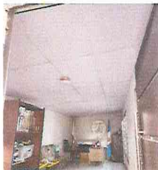
Foto 10: Sustitución e instalación de cielo falso de PVC en dirección
