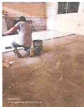
Foto 11: Sustitución de piso cerámico en corredor y aula.
