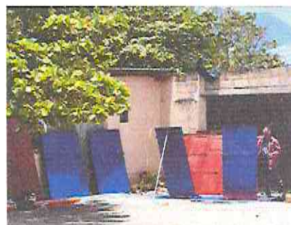
Foto 4: Mantenimiento de puertas de metal (lijado, cambio de tubo, cepillado y aplicación de pintura).
