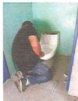
Foto 8: Sustitución e instalación de inodoros de una pieza marca Corona estilo Oporto Elogado en baños.
