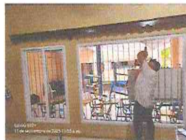
Foto 12: Fabricación e instalación de ventanas de PVC en aula.
