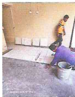
Foto 11: Sustitución de piso cerámico en corredor y aula.
