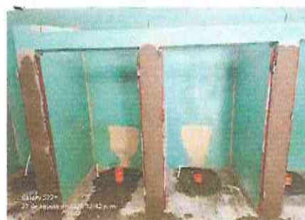
Foto 6: Repello en muros interior y exterior en baños.
