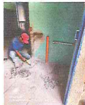
Foto 2: Sustitución de tubería PVC línea principal agua potable en baños.
