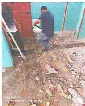
Foto 1: Sustitución de tubería PVC línea principal aguas negras en baños.
