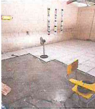
Foto13: Sustitución de piso cerámico en aula.
