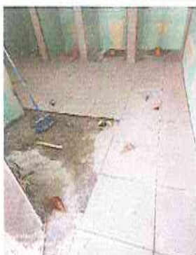
Foto 3: Sustitución de piso antideslizante en baños
