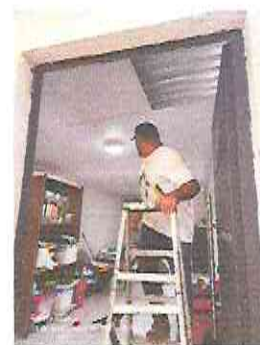
Foto 10: Sustitución e instalación de cielo falso de PVC en dirección
