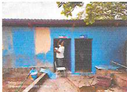
Foto 7: Pintura de muros interior y exterior de baños.
