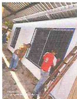
Foto 9: Instalación de balcón de metal en dirección.
