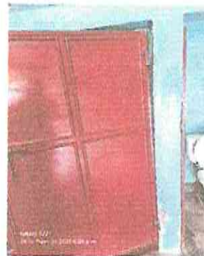
Foto 4: Mantenimiento de puertas de metal (lijado, cambio de tubo, cepillado y aplicación de pintura).
