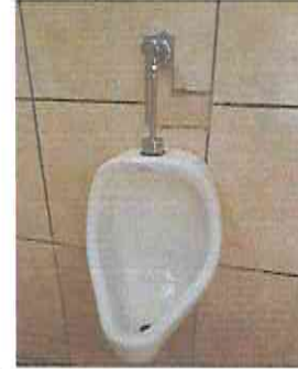
Foto 8: SUSTITUCION DE MINGITORIO (los mingitorios no funcionan son demasiado antiguos y es un pestilencia que se acumula, por tal razon la opf decidió cambiarlos, el precio incluye revision de tuberías).
