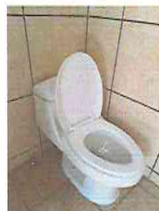
Foto 6: SUSTITUCIÓN DE INODOROS AMERICAN STAR (los 9 sanitarios estan en malas condiciones, en varias veces se han remozado y no funcionan, y la opf decidió cambiarios por unos de alta calidad)
