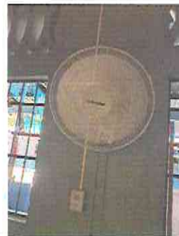
Foto 14: SUSTITUCION E INSTALACION DE VENTILADORES EN LA PARED DE LA AULAS.
