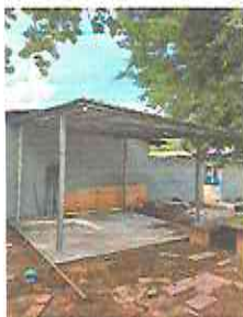
Foto1: 1. INSTALACIÓN DE ESTRUCTURA DE METAL, INLCUYE LAMINA (galera para cubrir el rotoplast y la bomba de agua)
