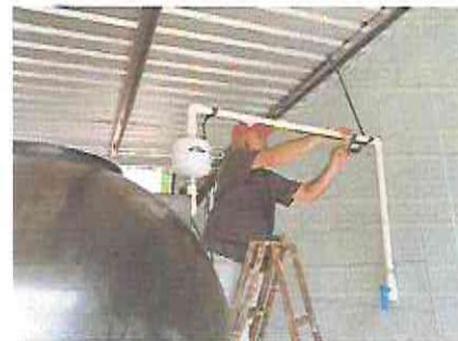
Foto 12: SUMINISTRO E INSTALACION DE BOMBA DE AGUA DE 0.75 HP (Bombeará agua del rotoplast a los baños y lavamanos e incluye instalacion de tuberías en baños y lavamanos)
