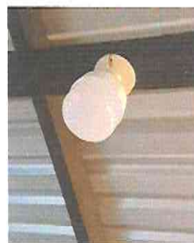
FOTO 16: SUSTITUCIÓN DE PLAFONERAS
