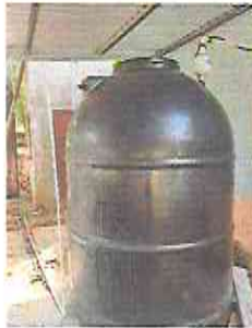
Foto 11: SUSTITUCIÓN DE DEPÓSITO DE AGUA DE 2500 LTS
