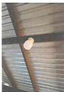
Foto 15: SUSTITUCIÓN DE FOCOS AHORRADORES
