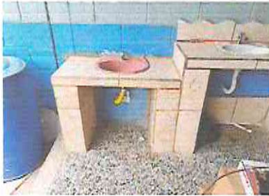
Foto 7: INSTALACIÓN DE LAVAMANOS DE CONCRETO CON ACCESORIOS. DE 1.5 METROS LINEALES (estarán ubicados en lugares separados).
