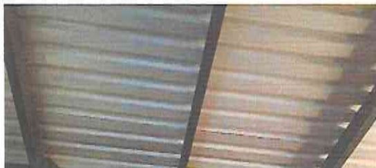
Foto 2: MANTENIMIENTO A ESTRUCTURA DE SOPORTE DE METAL
