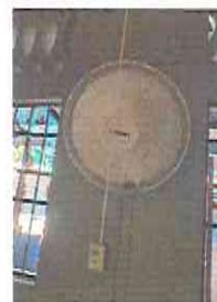
FOTO 18: INSTALACIÓN DE DUCTO ELÉCTRICO
