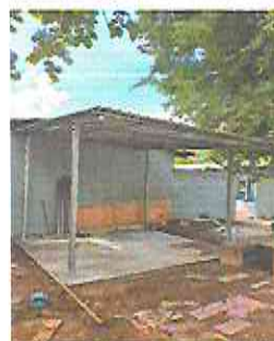
Foto 4: INSTALACIÓN DE PISO DE TORTA DE CONCRETO (aca se construirá la galera de la foto 1, donde irá el rotoplast y la bomba de agua).
