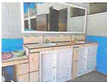
Foto 3: INSTALACIÓN DE PUERTAS DE PVC EN ÁREA DE LAVAMANOS 1.30 X 1.30 (se construirán para evitar que los niños se metan debajo de los lavamanos y quiebren las tuberías y como bodega)
