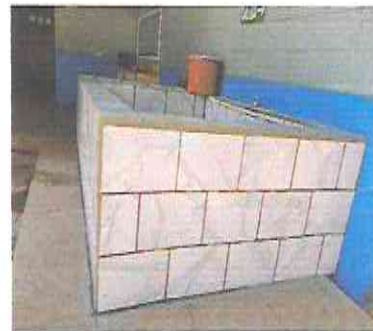
Foto 10: INSTALACION DE AZULEJO EN PILA
