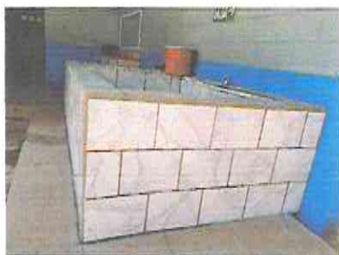
Foto 5: NSTALACION DE PISO ANTIDESLIZANTE EN ÁREA DE PILA
