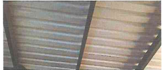
Foto 2: MANTENIMIENTO A ESTRUCTURA DE SOPORTE DE METAL
