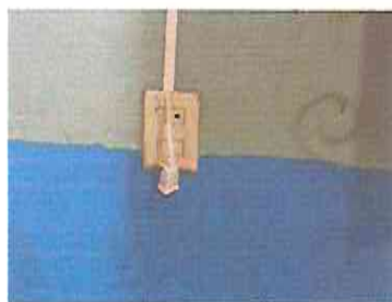
FOTO 17: SUSTITUCIÓN DE INTERRUPTORES DOBLES
