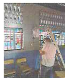
FOTO 18: INSTALACIÓN DE DUCTO ELÉCTRICO
