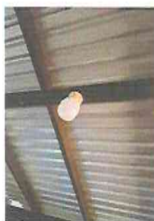
Foto 15: SUSTITUCIÓN DE FOCOS AHORRADORES
