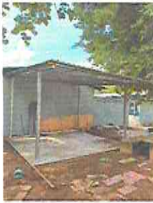
Foto1: 1. INSTALACIÓN DE ESTRUCTURA DE METAL, INLCUYE LAMINA (galera para cubrir el rotoplast y la bomba de agua)
