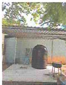
Foto 11: SUSTITUCIÓN DE DEPÓSITO DE AGUA DE 2500 LTS
