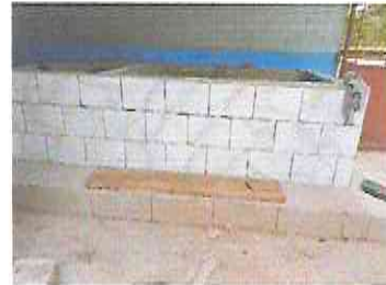
Foto 10: INSTALACION DE AZULEJO EN PILA
