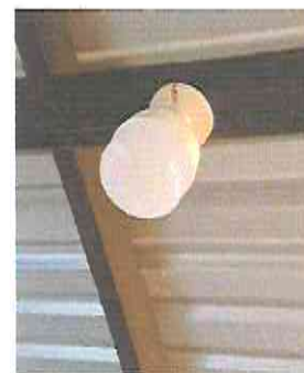
FOTO 16: SUSTITUCIÓN DE PLAFONERAS
