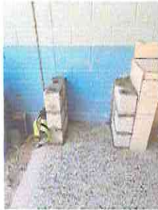
Foto 7: INSTALACIÓN DE LAVAMANOS DE CONCRETO CON ACCESORIOS. DE 1.5 METROS LINEALES (estarán ubicados en lugares separados).
