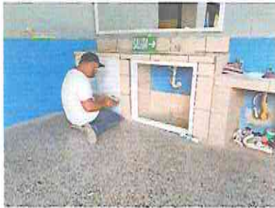
Foto 3: INSTALACIÓN DE PUERTAS DE PVC EN ÁREA DE LAVAMANOS 1.30 X 1.30 (se construirán para evitar que los niños se metan debajo de los lavamanos y quiebren las tuberías y como bodega)
