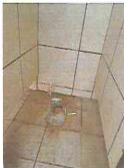
Foto 13: INSTALACIÓN DE INODOROS (ESTE PRECIO ES POR LA INSTALACIÓN DE CADA UNO DE LOS 9 INODOROS NUEVOS QUE SE PRETENDEN INSTALAR)
