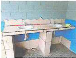
Foto 9: SUSTITUCION DE LLAVES PARA LAVAMANOS
