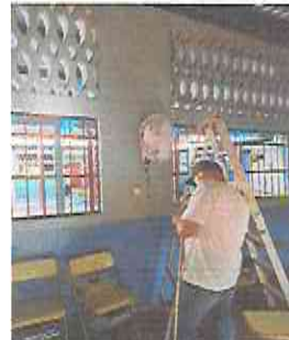
Foto 14: SUSTITUCION E INSTALACION DE VENTILADORES EN LA PARED DE LA AULAS.
