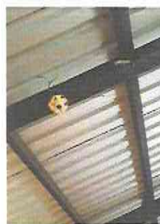
FOTO 16: SUSTITUCIÓN DE PLAFONERAS
