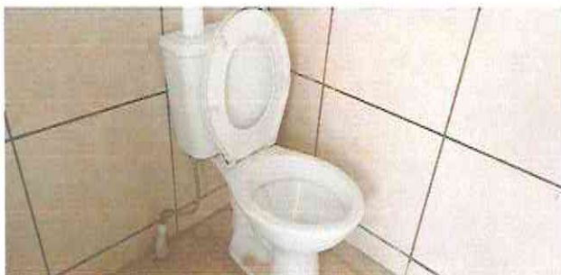
Foto 13: INSTALACIÓN DE INODOROS (ESTE PRECIO ES POR LA INSTALACIÓN DE CADA UNO DE LOS 9 INODOROS NUEVOS QUE SE PRETENDEN INSTALAR)
