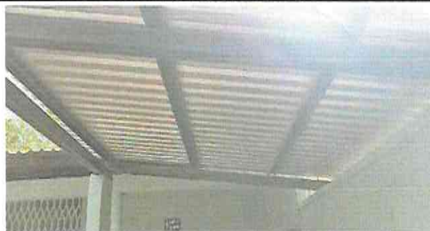
Foto 2: MANTENIMIENTO A ESTRUCTURA DE SOPORTE DE METAL
