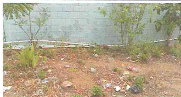
Foto 4: INSTALACIÓN DE PISO DE TORTA DE CONCRETO (aca se construirá la galera de la foto 1, donde irá el rotoplast y la bomba de agua).
