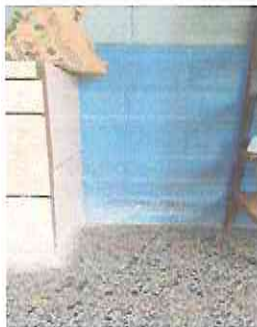
Foto 7: INSTALACIÓN DE LAVAMANOS DE CONCRETO CON ACCESORIOS. DE 1.5 METROS LINEALES (estarán ubicados en lugares separados).
