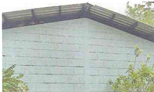
Foto1: 1. INSTALACIÓN DE ESTRUCTURA DE METAL, INLCUYE LAMINA (galera para cubrir el rotoplast y la bomba de agua)
