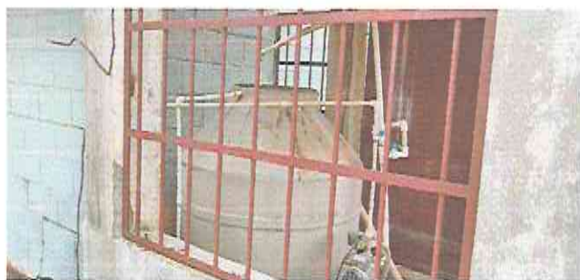
Foto 11: SUSTITUCIÓN DE DEPÓSITO DE AGUA DE 2500 LTS
