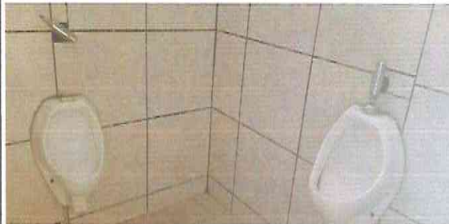
Foto 8: SUSTITUCION DE MINGITORIO (los mingitorios no funcionan son demasiado antiguos y es un pestilencia que se acumula, por tal razon la opf decidió cambiarlos, el precio incluye revision de tuberías).
