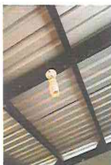
Foto 15: SUSTITUCIÓN DE FOCOS AHORRADORES
