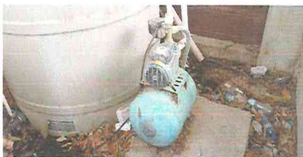
Foto 12: SUMINISTRO E INSTALACION DE BOMBA DE AGUA DE 0.75 HP (Bombeará agua del rotoplast a los baños y lavamanos e incluye instalacion de tuberías en baños y lavamanos)
