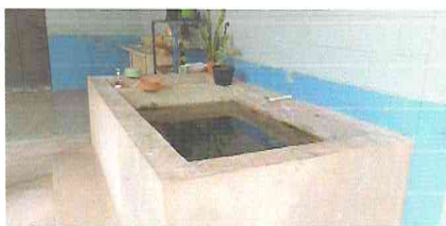
Foto 10: INSTALACION DE AZULEJO EN PILA
