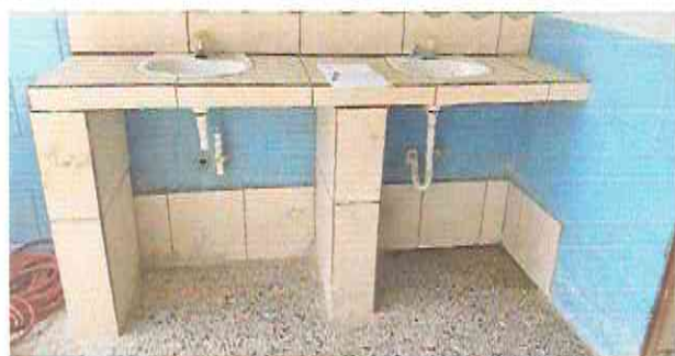
Foto 3: INSTALACIÓN DE PUERTAS DE PVC EN ÁREA DE LAVAMANOS 1.30 X 1.30 (se construirán para evitar que los niños se metan debajo de los lavamanos y quiebren las tuberías y como bodega)
