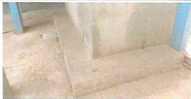
Foto 5: NSTALACION DE PISO ANTIDESLIZANTE EN ÁREA DE PILA
