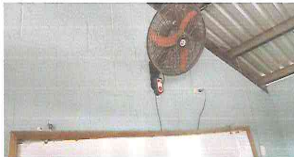
Foto 14: SUSTITUCION E INSTALACION DE VENTILADORES EN LA PARED DE LA AULAS.
