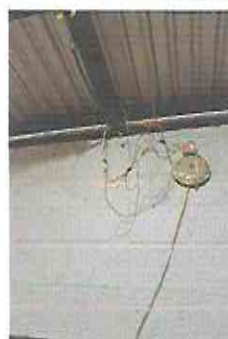
FOTO 18: INSTALACIÓN DE DUCTO ELÉCTRICO
