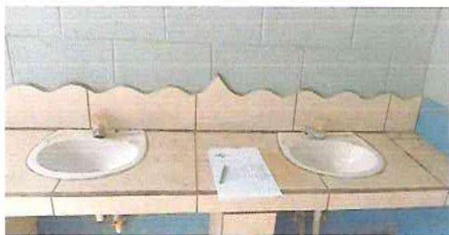
Foto 9: SUSTITUCION DE LLAVES PARA LAVAMANOS
