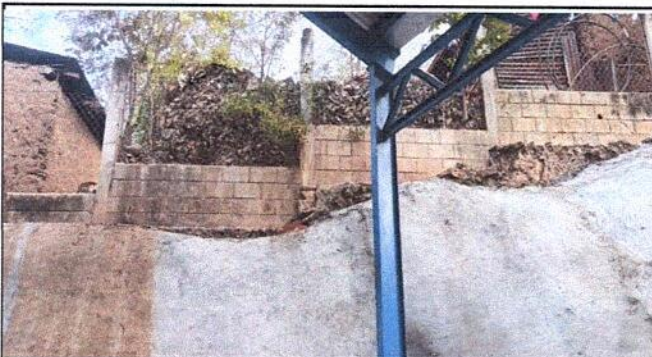
Foto 3: protección del muro existente ya que se encontraba en mal estado y podía colapsar y a la vez resguardando la seguridad de los niños.
