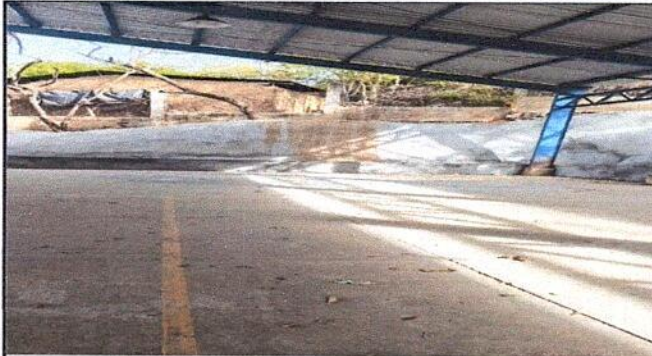
Foto1: Protección de muro existente con electromalla y concreto 5800 PSI
