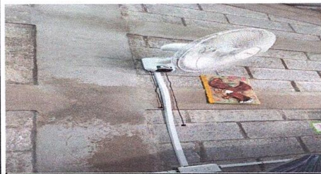
sustitucion de ventiladores aereos.
