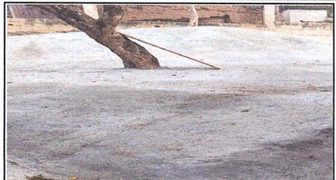
Foto 2. Protección de muro existente, siendo necesario para el resguardo de los estudiantes de los tres niveles educativos.
