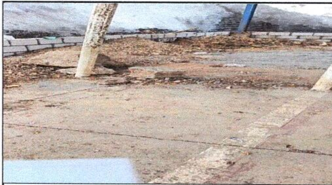
Foto1: Instalacion de cuneta de concreto
