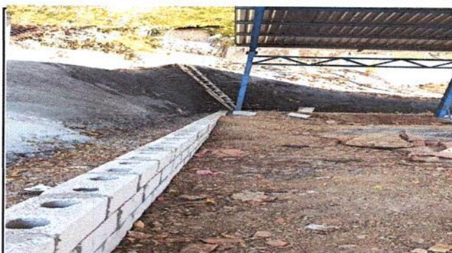
Foto 4: Levantamiento de tres hiladas de block con repello y cernido para area de cancha de juegos.
