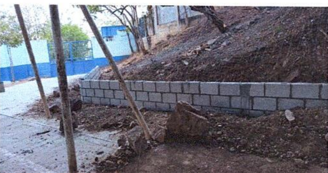
Foto 6: Levantamiento de 3 hiladas de block con repello y cernido para area de cancha de juegos.
