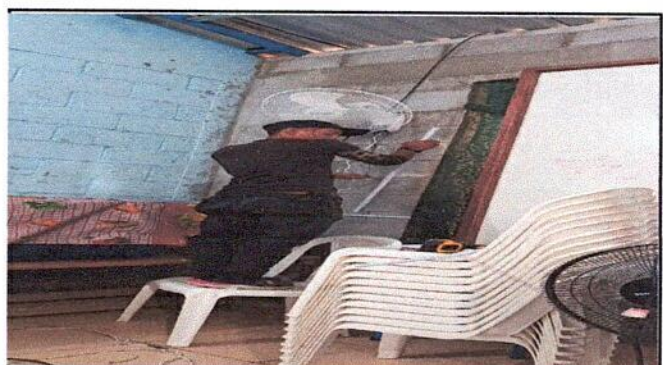
Foto 4: sustitucion de ventiladores aereos
