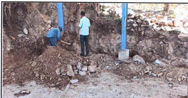
Foto 5: Levantamiento de 3 hiladas de block con repello y cernido esto evitara que el agua ingrese en el area afectada y se aga charco con lodo, ya que es la entrada principal al establecimiento educativo.
