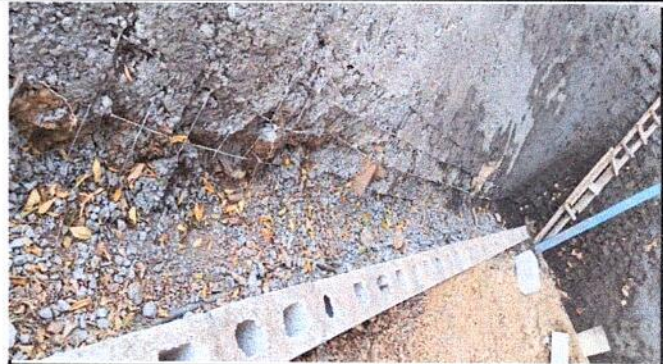
Foto 2. Instalacion de cuneta de concreto
