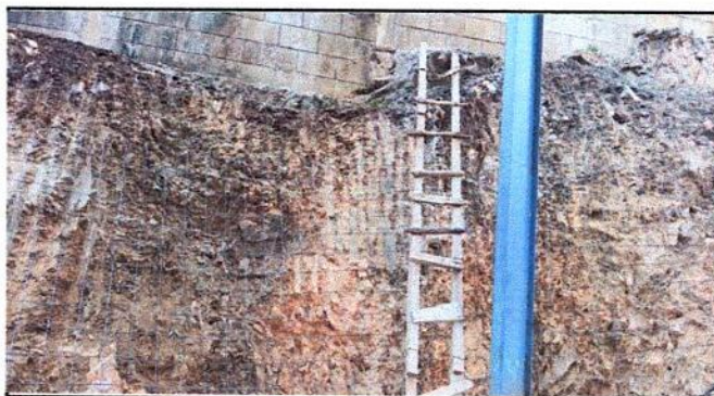
Foto 3: protección del muro existente ya que se encontraba en mal estado y podía colapsar y ala ves resguardando la seguridad de los niños.
